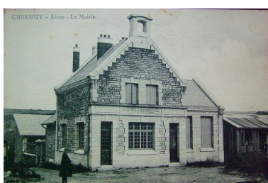
Vue de la mairie juste après sa reconstruction (coll. part). Phot. Inès Guérin IVR22_20050200431NUCAB
