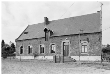
Vue de l'élévation sur cour de l'étable. Phot. Christiane Riboulleau IVR22_19900202497Z
