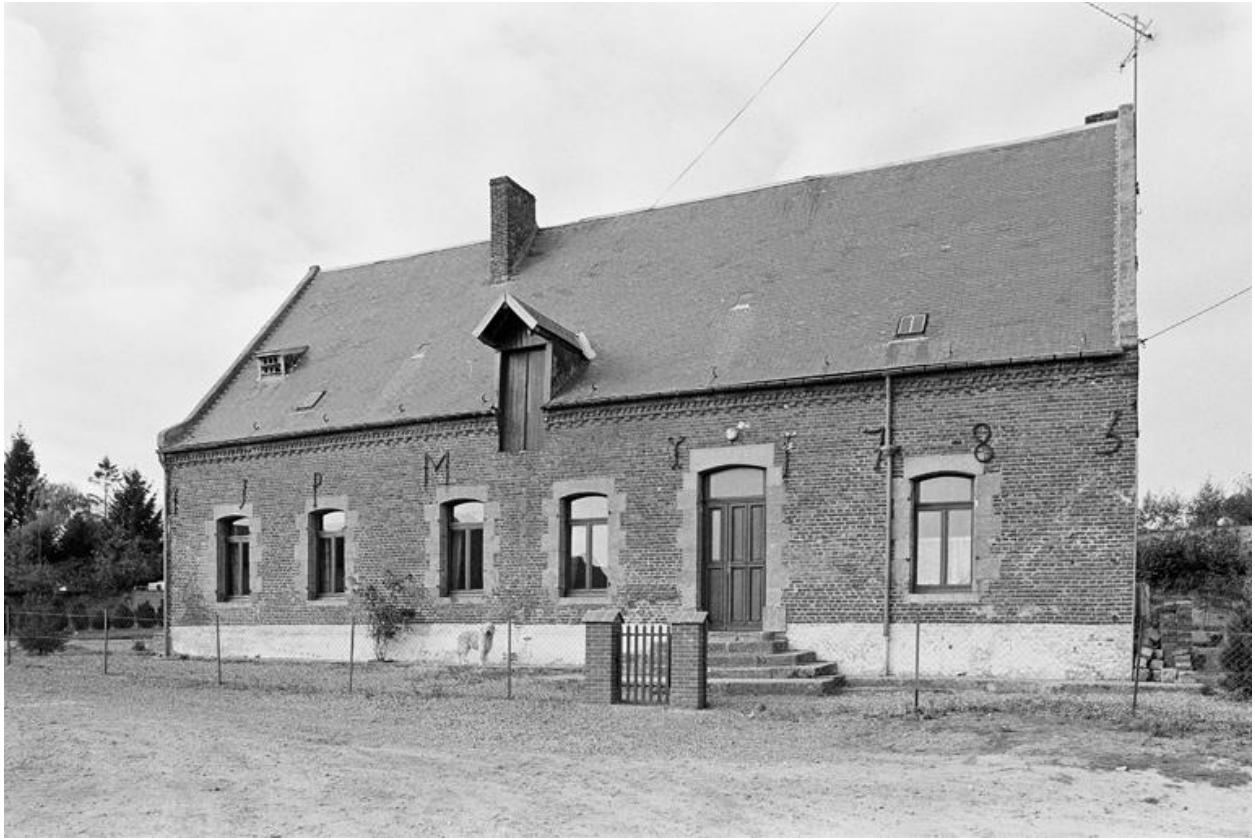
Vue de l'élévation sur cour de l'étable.
