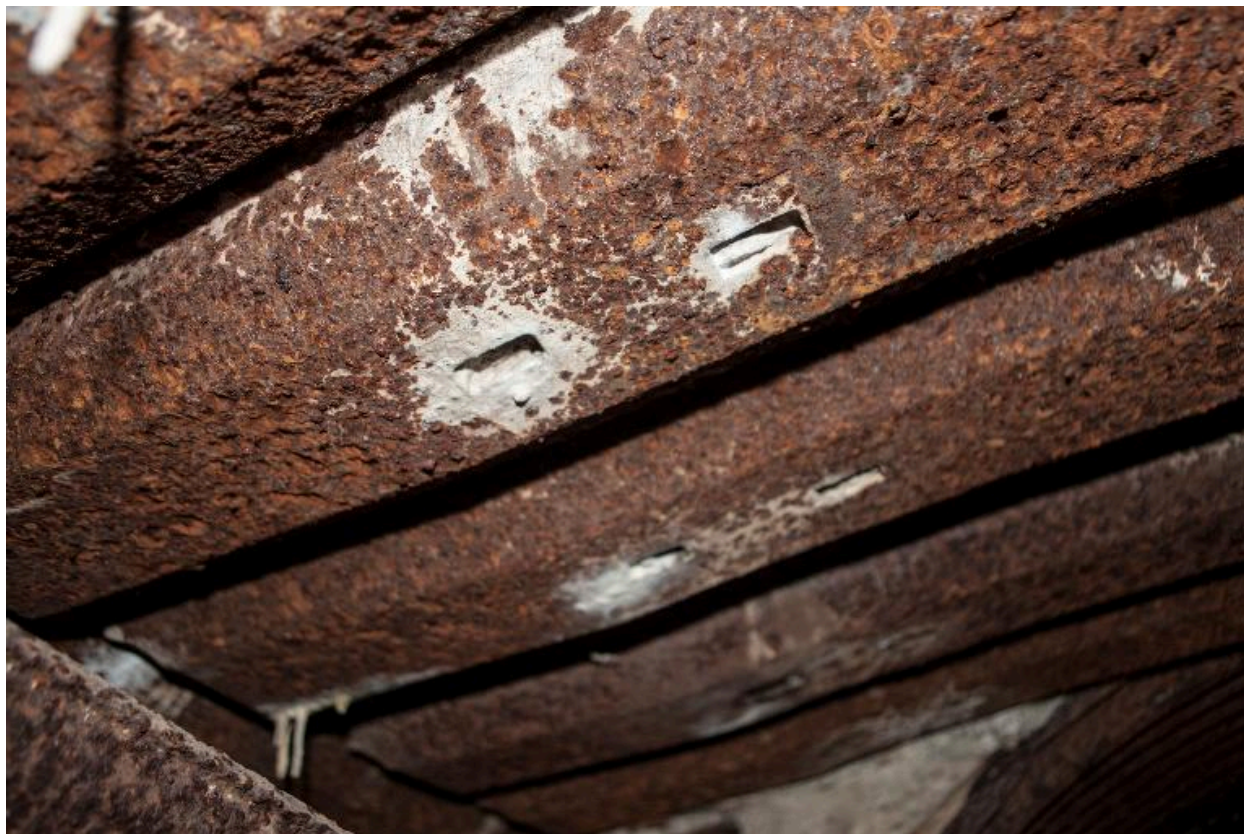
Palplanche servant de coffrage
