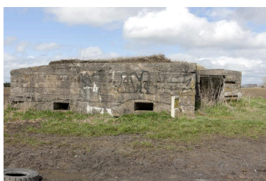
Vue vers le nord Phot. Jean-Marc Ramette IVR31_20146203035NUCA
