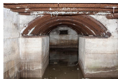
La salle nord, depuis le couloir Phot. Hubert Bouvet IVR31_20156200299NUC4A
