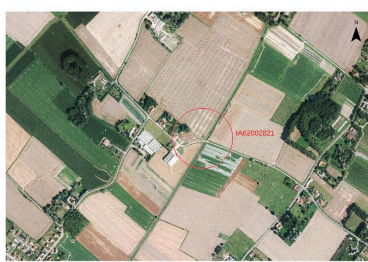
Situation de l'édifice sur une photographie aérienne de 2014 Phot. Jean-Marc Ramette IVR32_20176200279NUCA
