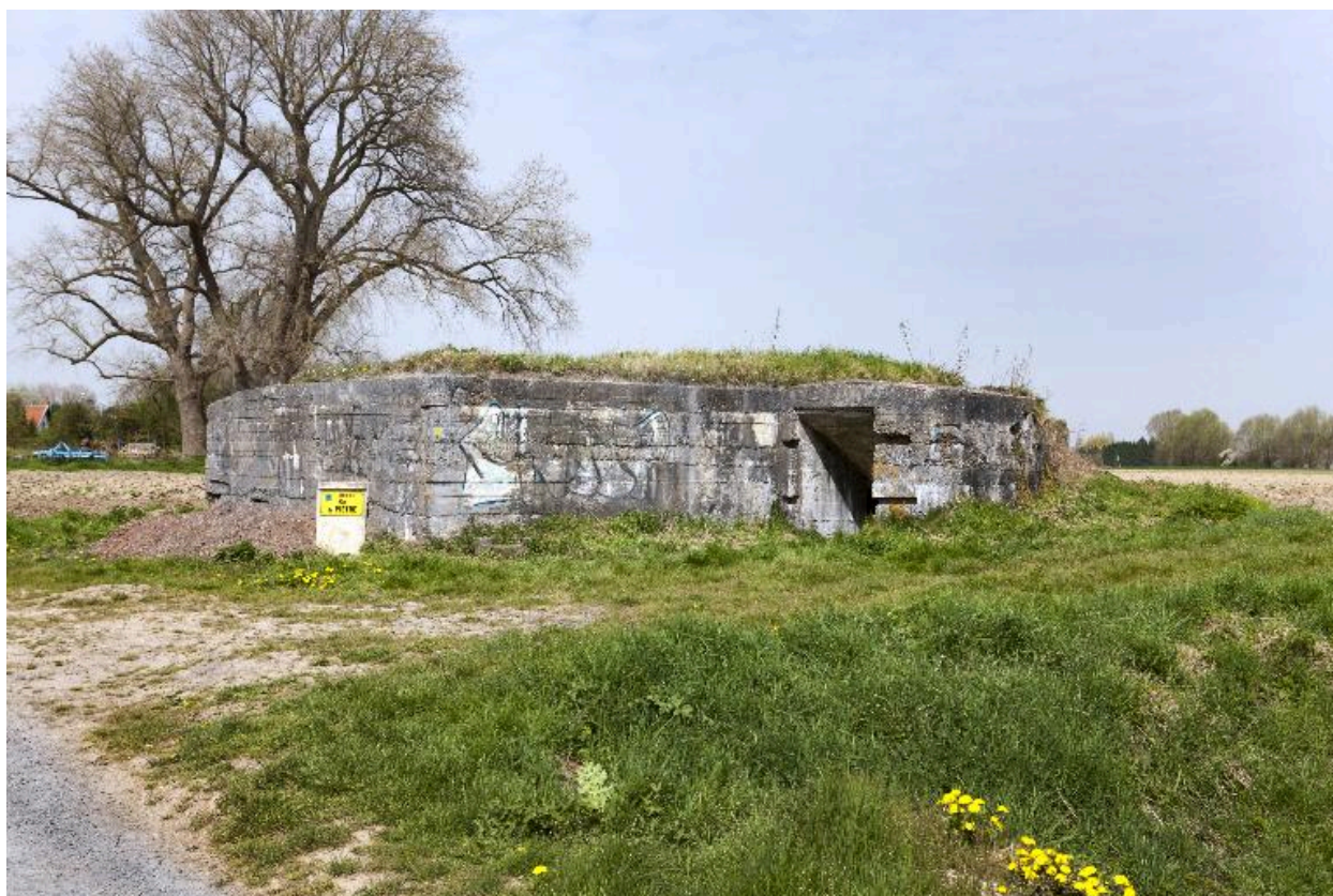
Vue générale vers le nord-est
