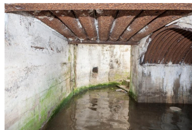
Couloir, vers l'entrée. A gauche la salle est
