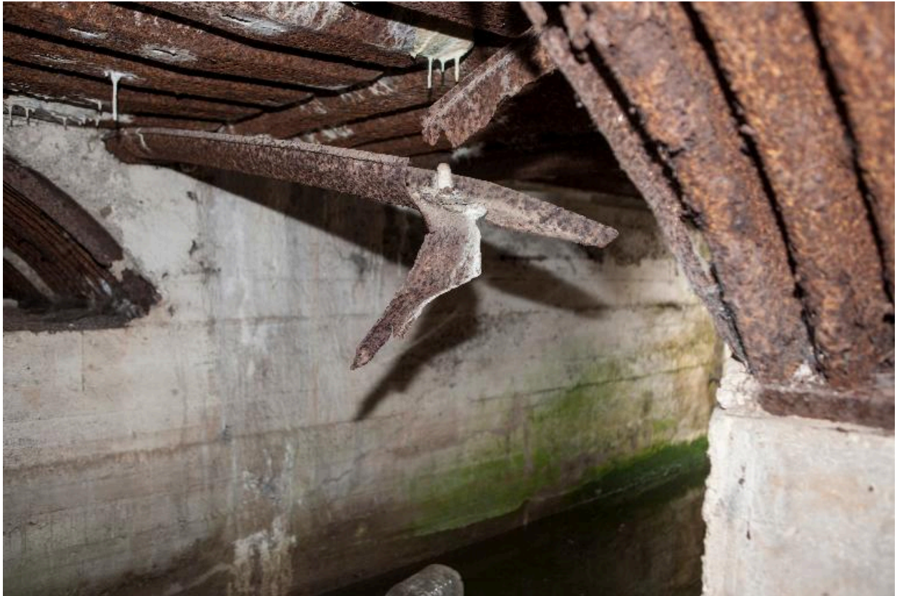
Détail d'une tôle de coffrage
