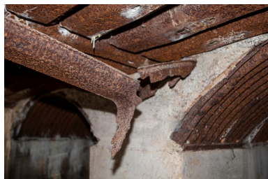
Détail de coffrage Phot. Hubert Bouvet
