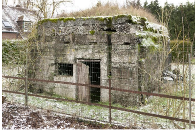
Elévation sud. Entrée Phot. Jean-Marc Ramette IVR31_20145904048NUCA
