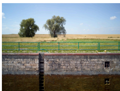
Site d'écluse n°7 de Graincourt-lès-Havrincourt. Phot. Pierre Thibaut IVR32_20216200672NUCA
