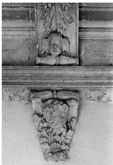
Détail de consoles. Phot. Thierry Lefébure IVR22_19910200132X
