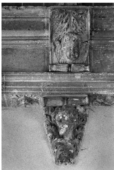
Détail de consoles. Phot. Thierry Lefébure IVR22_19910200179X
