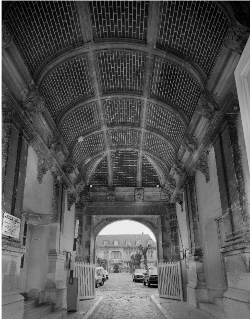
Vue du passage d'entrée.
