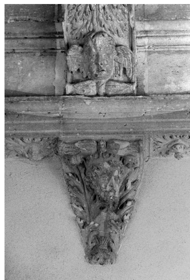
Détail de consoles. Phot. Thierry Lefébure IVR22_19910200128X
