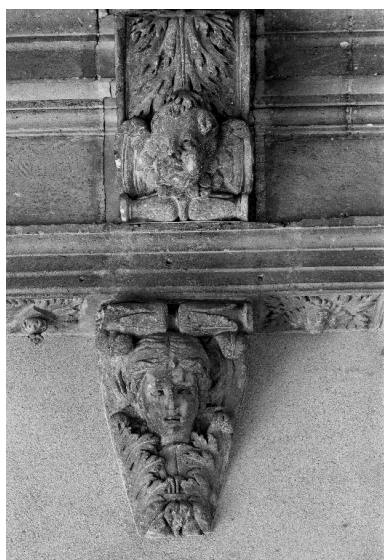
Détail de consoles. Phot. Thierry Lefébure IVR22_19910200129X
