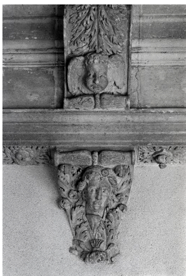
Détail de consoles. Phot. Thierry Lefébure IVR22_19910200130X
