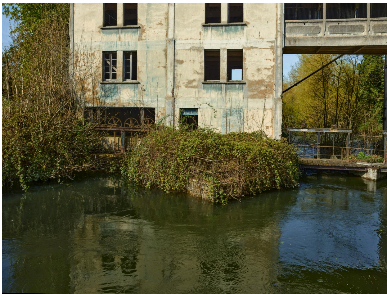
Vannage de la grande roue et du musoir en éperon du côté sud.
