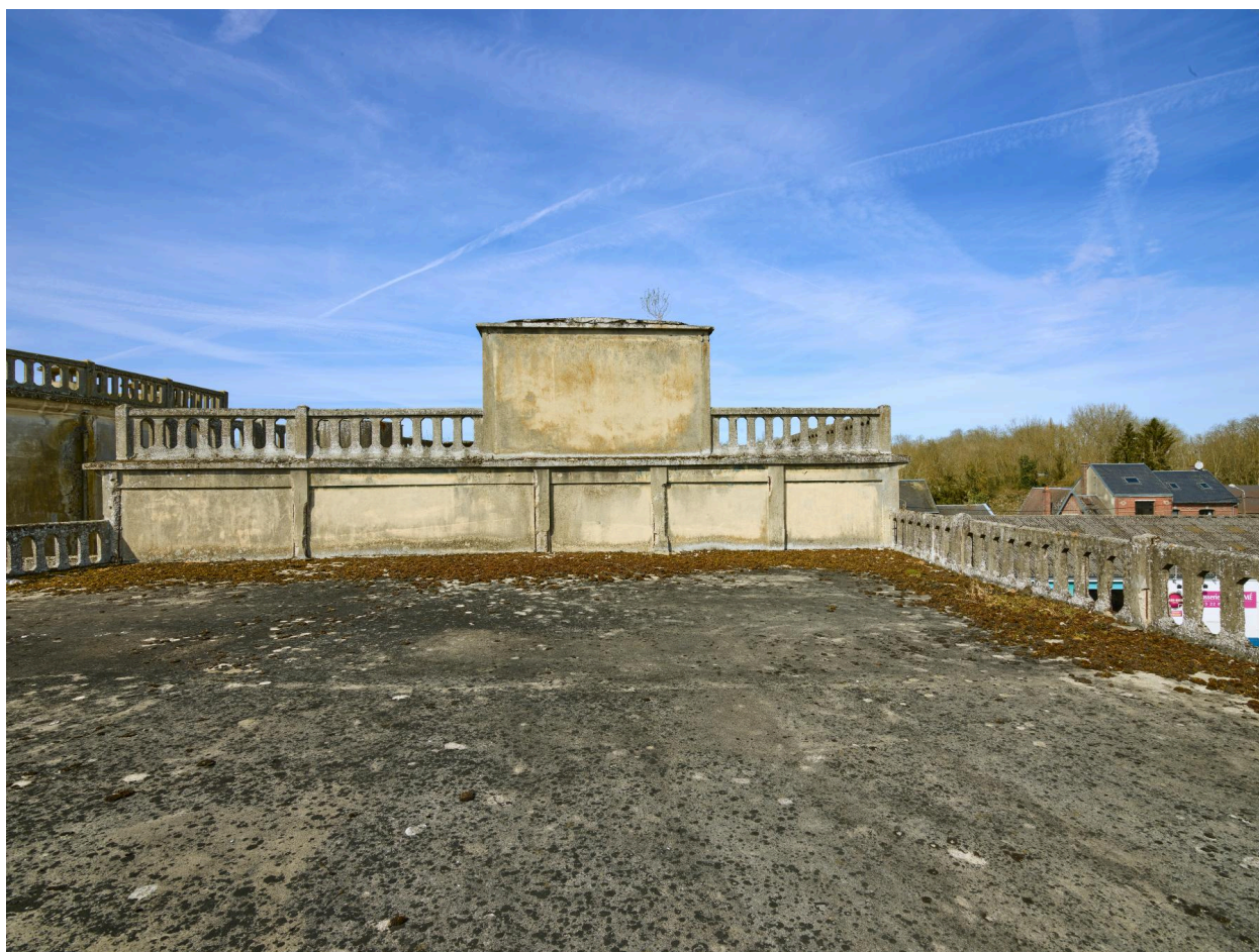
Toit-terrasse de la minoterie.
