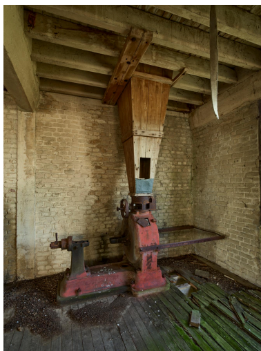
Trémie. Phot. Thierry Lefébure IVR32_20228000089NUCA
