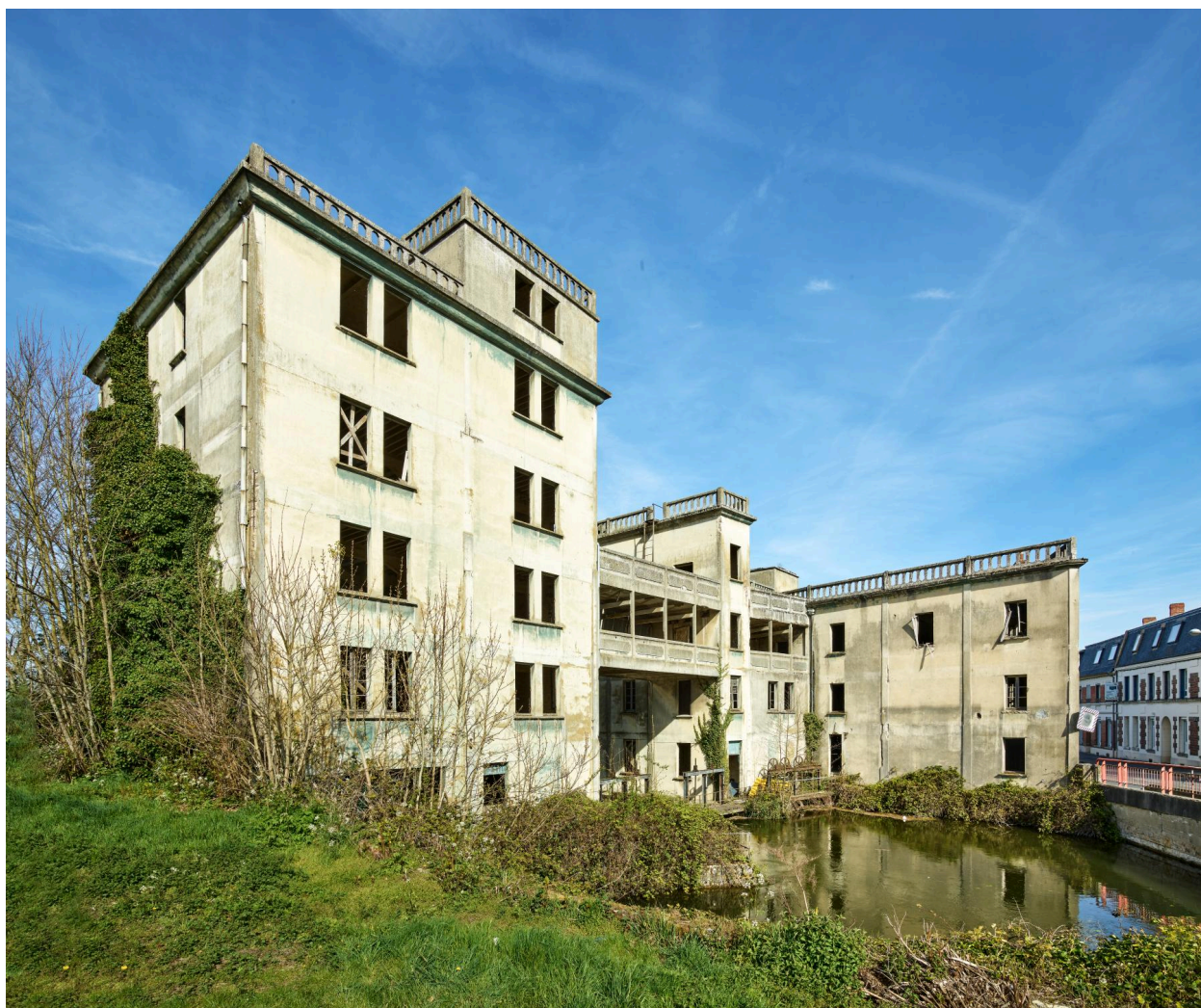
Vue générale sud-est de la minoterie.
