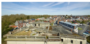
Terrasse des silos et magasins.
