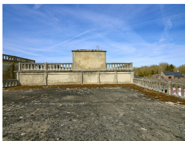
Toit-terrasse de la minoterie.
