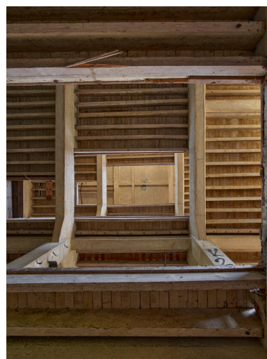
Passage des tremis à planchisters à chaque niveau de la minoterie. Phot. Thierry Lefébure IVR32_20228000103NUCA
