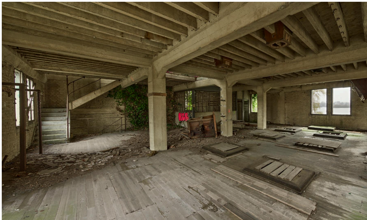
Intérieur du deuxième étage de la minoterie.
