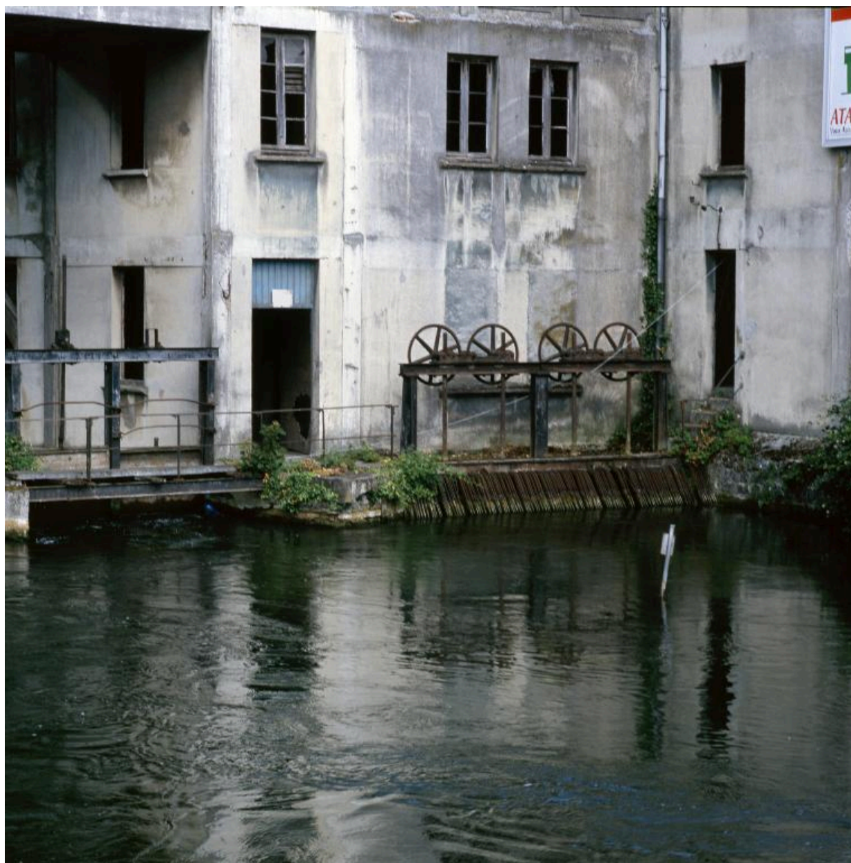
Vannage ouvrier de l'ancienne grande roue hydraulique et du musoir en éperon du côté sud.
