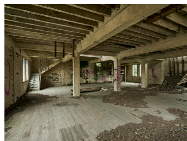
Salle des sasseurs. Phot. Thierry Lefébure IVR32_20228000085NUCA
