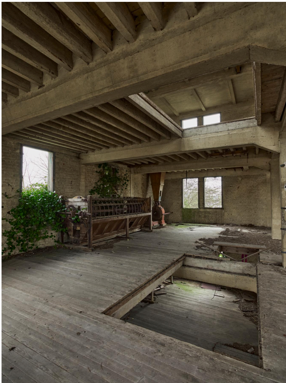
Ancienne salle des plansichters.
