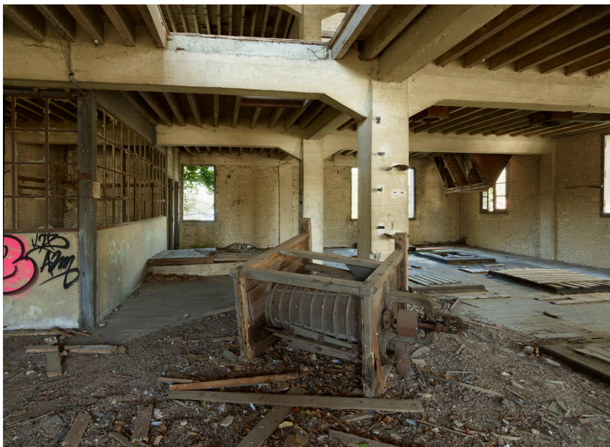
Intérieur du deuxième étage de la minoterie.
