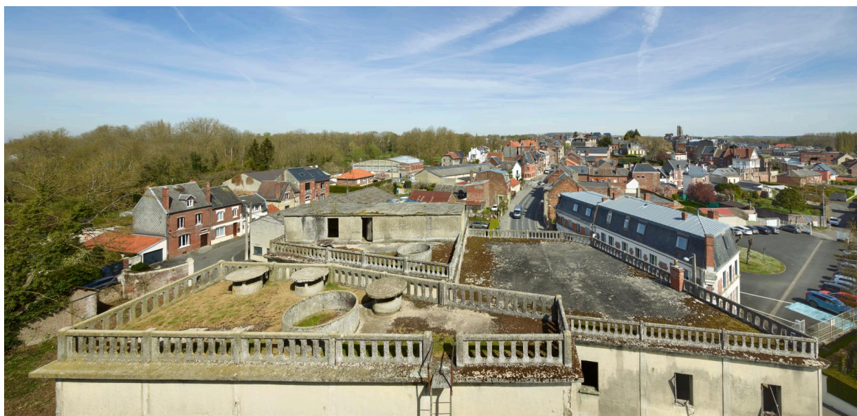
Terrasse des silos et magasins.
