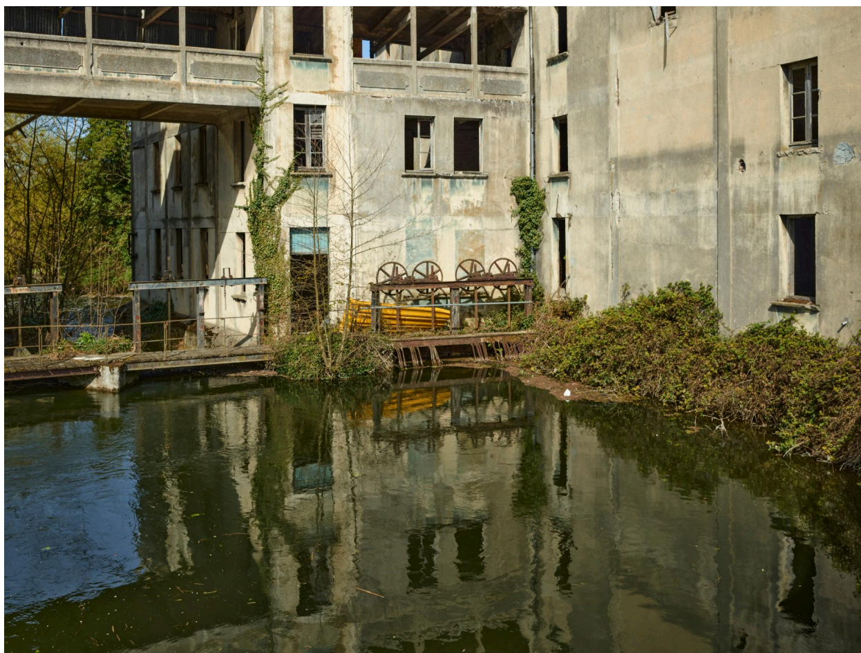
Vannage de la petite roue hydraulique.
