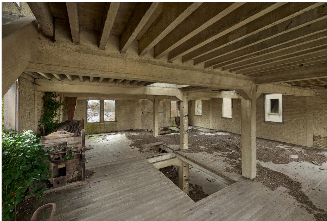
Intérieur du deuxième étage de la minoterie.
