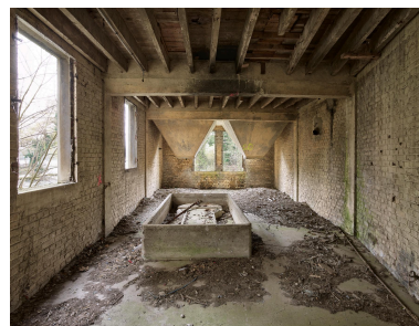
Salle à deux trémis en béton. Phot. Thierry Lefébure IVR32_20228000082NUCA
