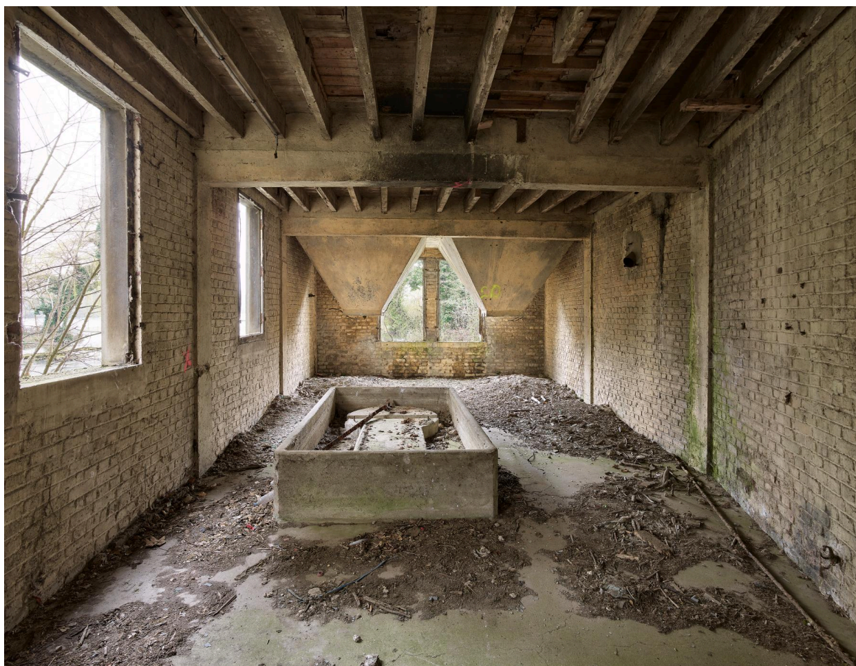
Salle à deux trémis en béton.
