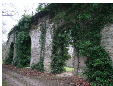
Etat actuel des soubassements . Phot. Pascale Touzet IVR22_20050200620NUCA
