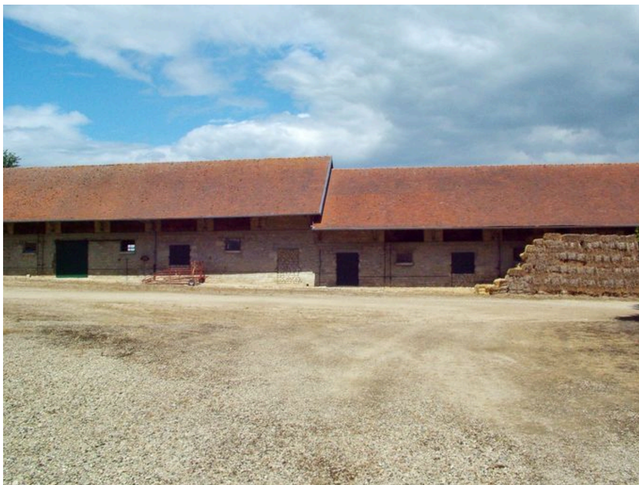
Dépendances de la ferme du château.
