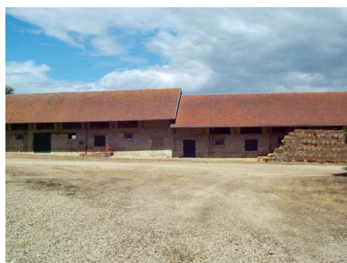
Dépendances de la ferme du château. Phot. Inès Guérin IVR22_20030202175NUCA
