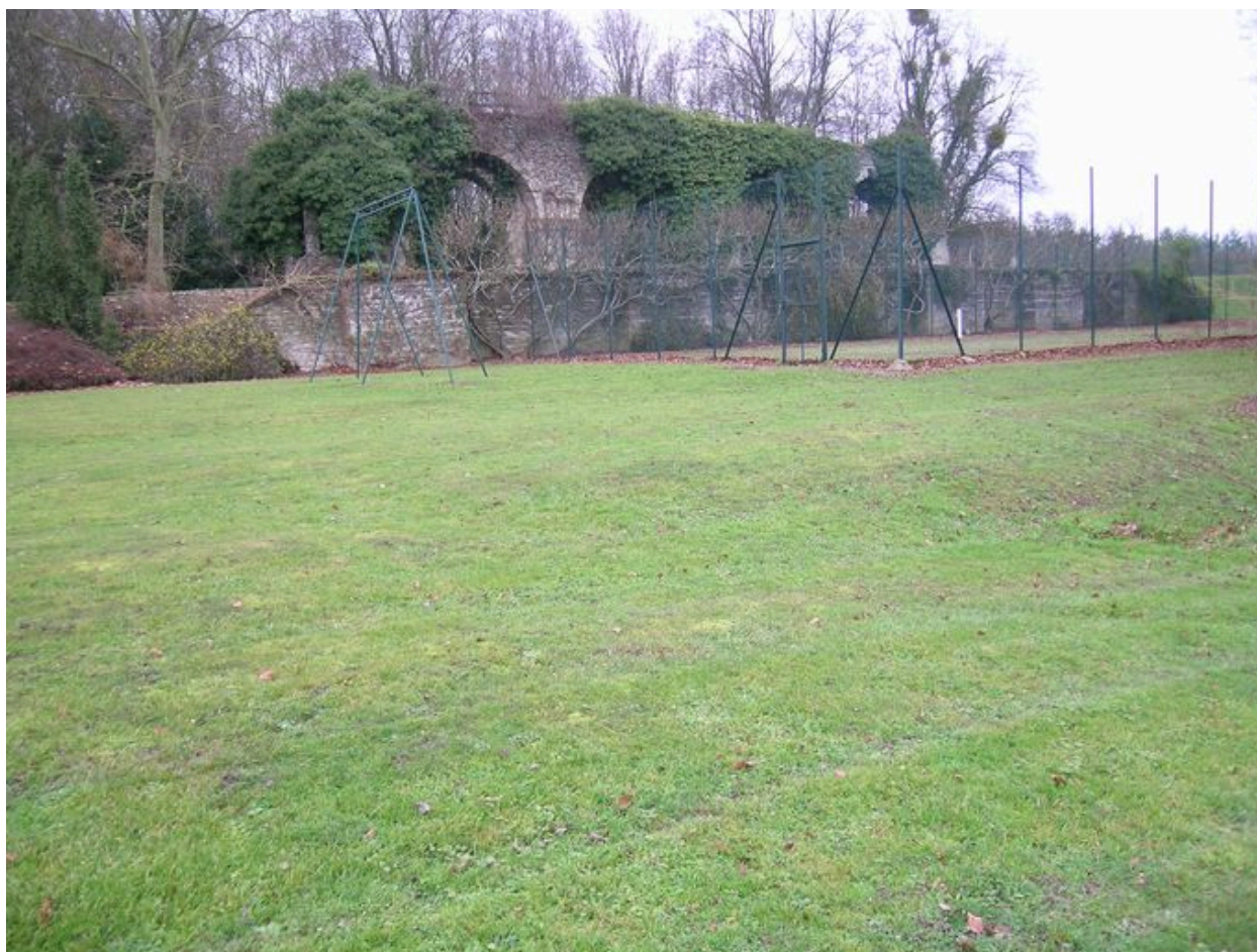
Arcades de l'ancien édifice
