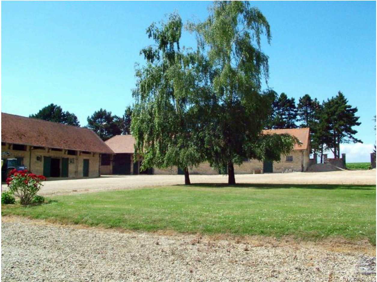
Dépendances de la ferme du château.
