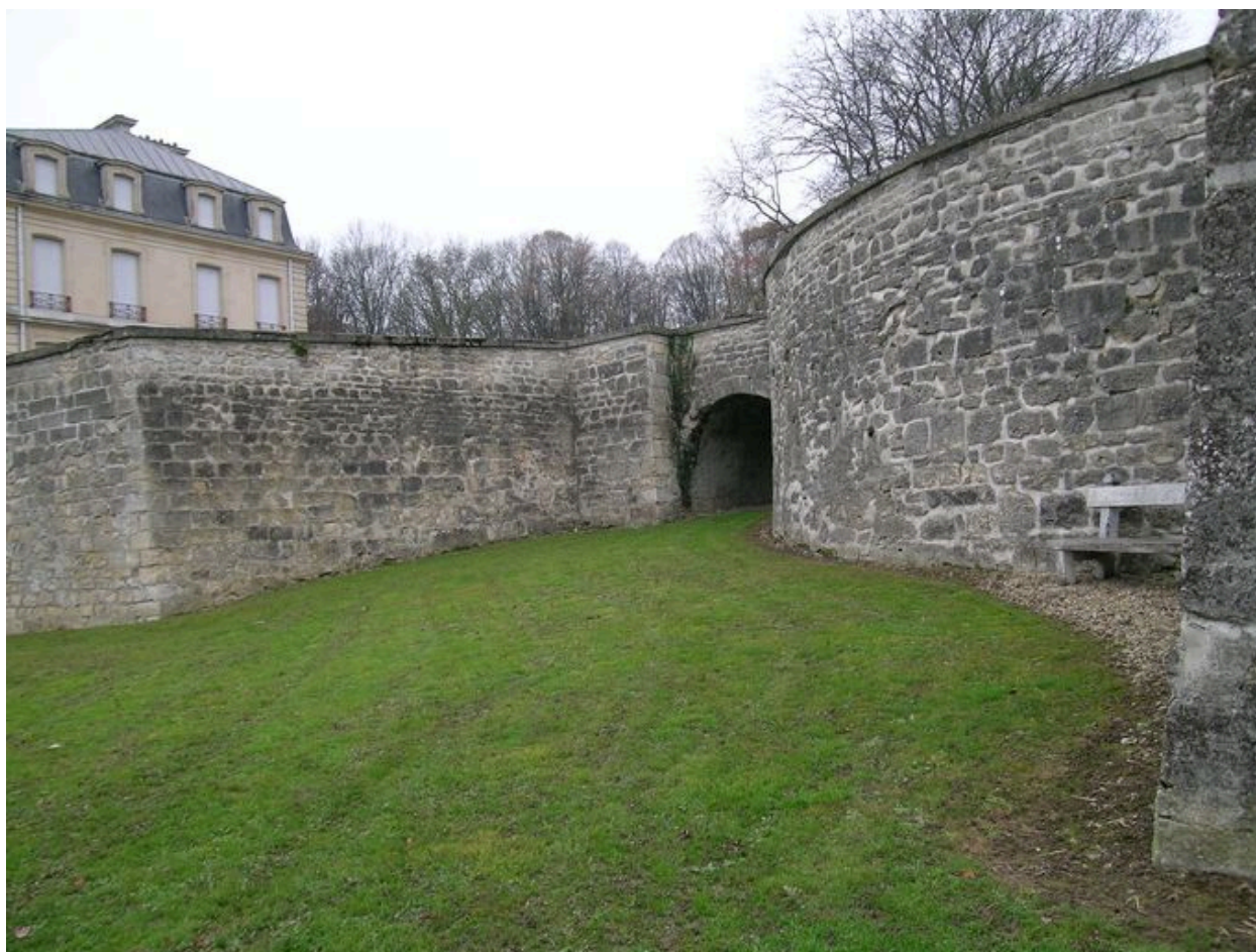
Soubassement de la terrasse percé d'un passage
