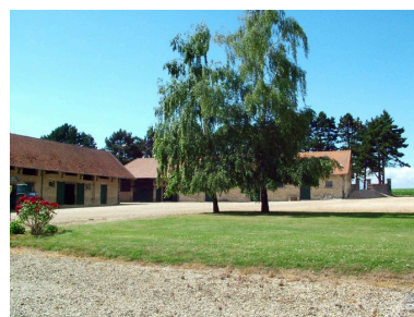
Dépendances de la ferme du château. Phot. Inès Guérin IVR22_20030202174NUCA
