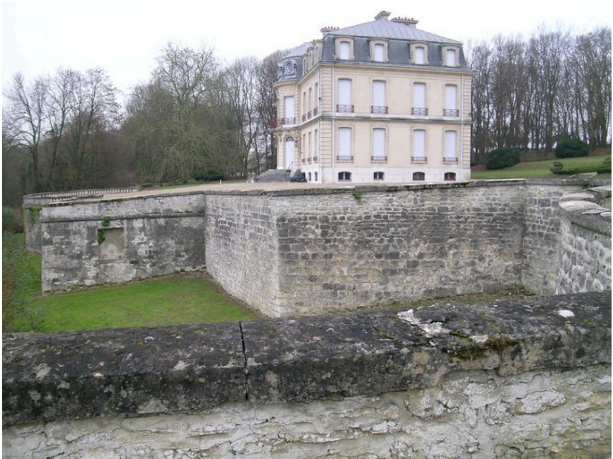
Vue latérale du château et de la terrasse.
