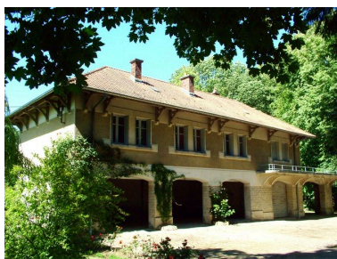
Vue des dépendances. Phot. Inès Guérin IVR22_20030202165NUCA
