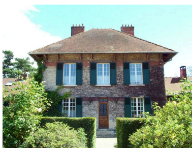
Vue du logis de la ferme du château. Phot. Inès Guérin IVR22_20030202173NUCA
