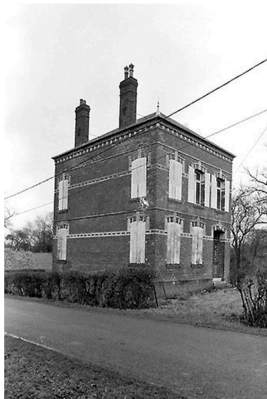
Maison non étudiée, 1 route départementale 744. Phot. Xavier-Philippe Guiochon IVR22_19970202382Z
