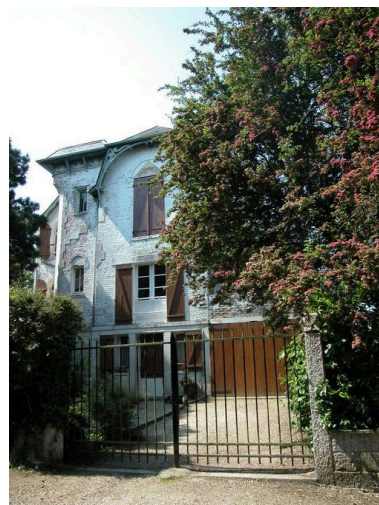
Vue d'ensemble depuis la rue en 2004, façade avec badigeon. Phot. Elisabeth Justome IVR22_20048001638NUCA
