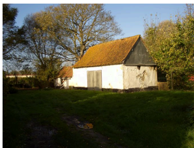
Vue des dépendances. Phot. Inès Guérin IVR22_20068005613NUCA
