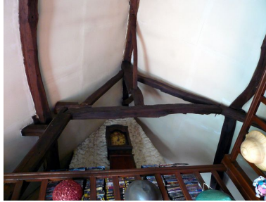
Vue détaillée d'une des fermes de la charpente. Phot. Inès Guérin IVR22_20078005494NUCA
