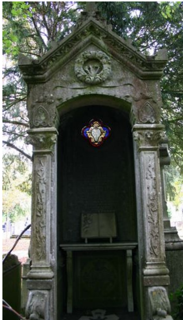
Détail de la façade antérieure du tombeau-chapelle. Phot. Caroline Vincent IVR22_20098001402NUCA
