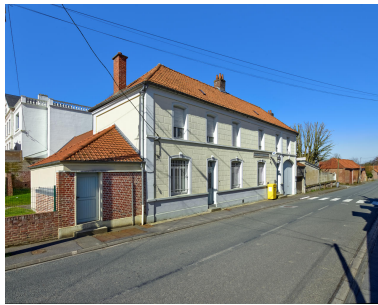
Vue de la façade depuis le sud. Phot. Thierry Lefébure IVR32_20236200335NUCA
