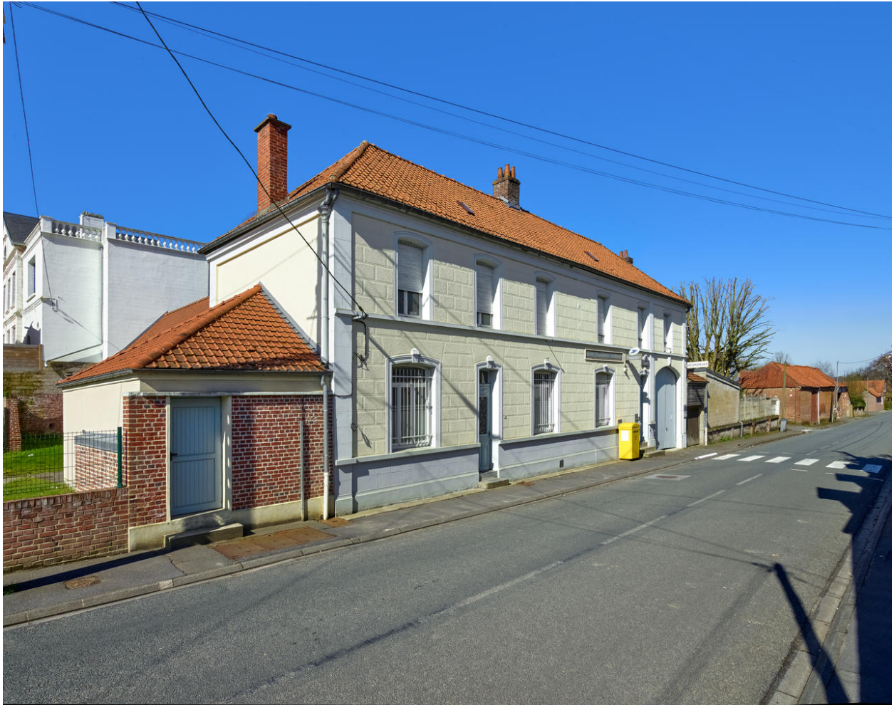
Vue de la façade depuis le sud.
