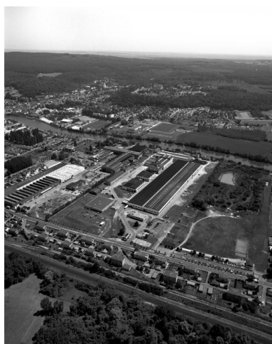
Vue aérienne de la Salpa, 1995. Phot. Sanson Aviation IVR22_19956000890X
