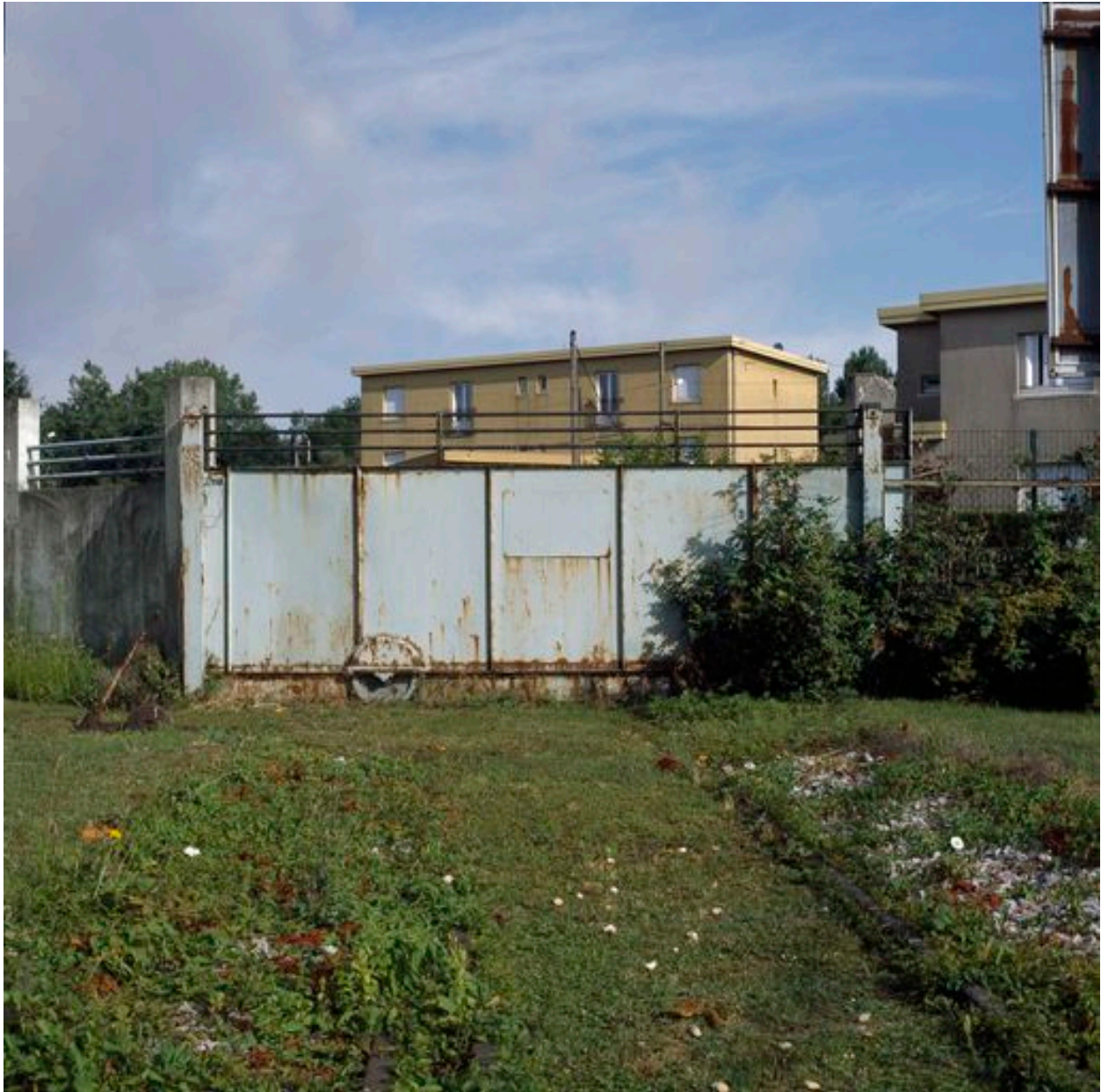
Entrée de la desserte ferroviaire rue Pasteur.
