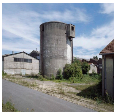
Décanteur. Phot. Thierry Lefébure IVR22_20106000553XA
