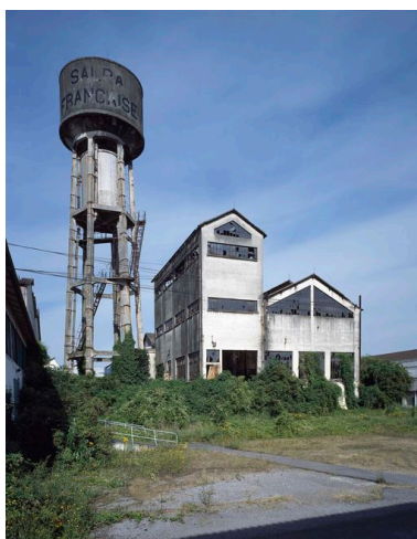
Château d'eau et centrale électrique. Phot. Thierry Lefébure IVR22_20106000535VA
