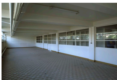
Réfectoire au sous-sol du bâtiment des bureaux. Phot. Thierry Lefébure IVR22_20106000567XA
