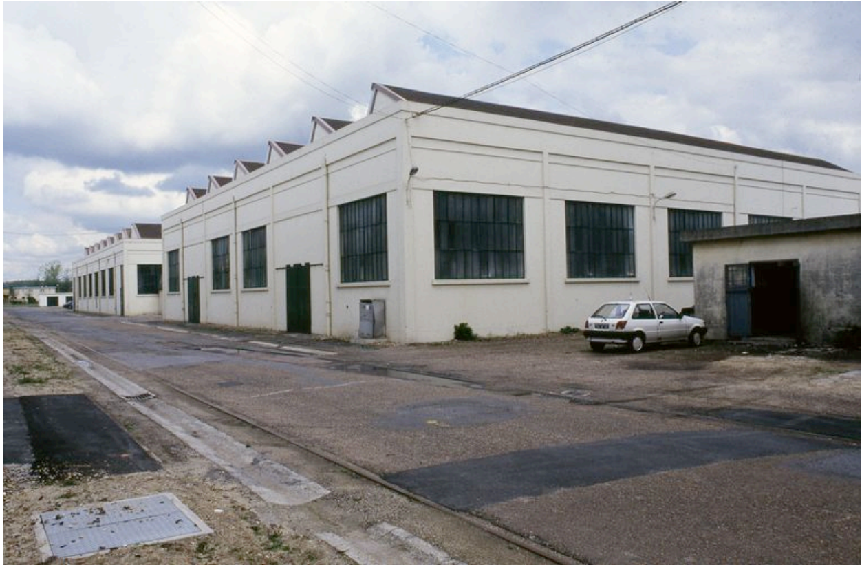
Atelier des enduits et d'entretien.
