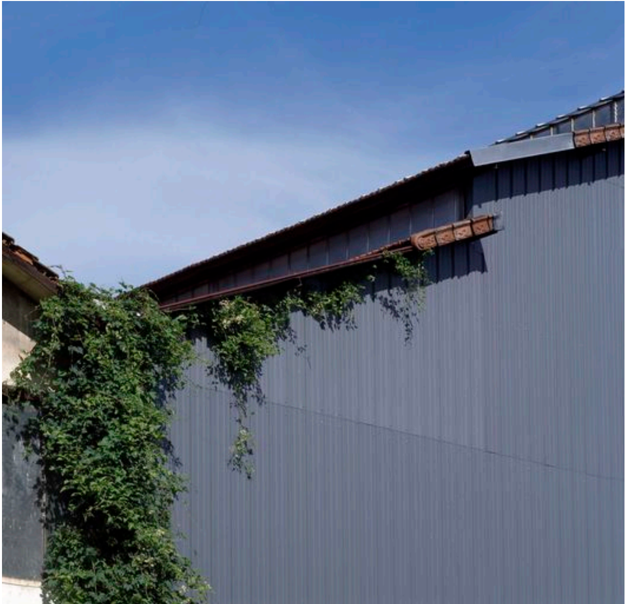
Détail de la bordure de rive de la feuturerie.
