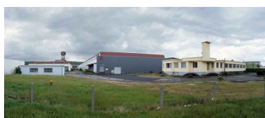
Vue panoramique du site de la Salpa prise vers le sud-ouest. Phot. Thierry Lefébure IVR22_20106000325NUCA
