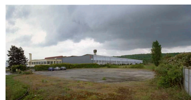
Vue panoramique prise vers le sud-est. Phot. Thierry Lefébure IVR22_20106000341NUCA
