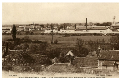
Vue des usines de la Salpa et de la papeterie depuis la rive gauche de l'Oise (AD Oise ; 4FI5066). Phot. Archives départementales de l'Oise (reproduction) IVR22_20106003304NUCAB
