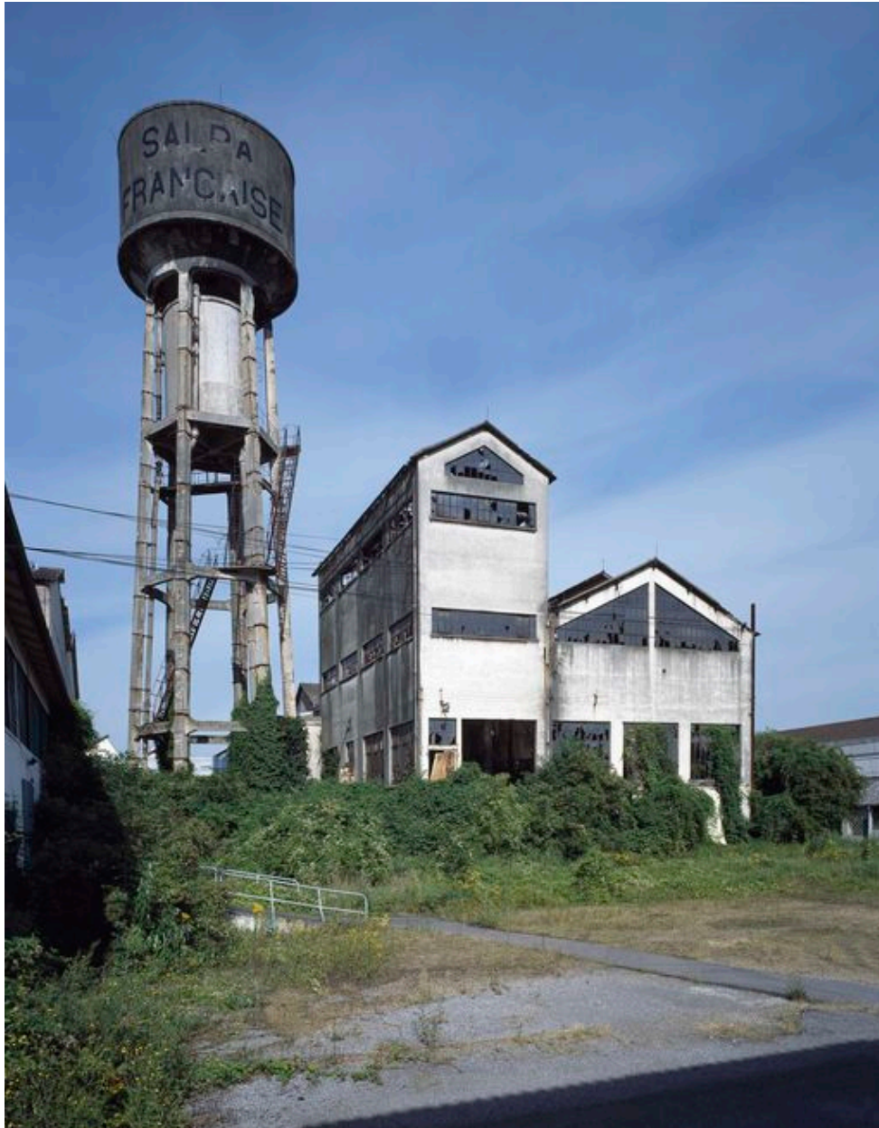
Château d'eau et centrale électrique.
