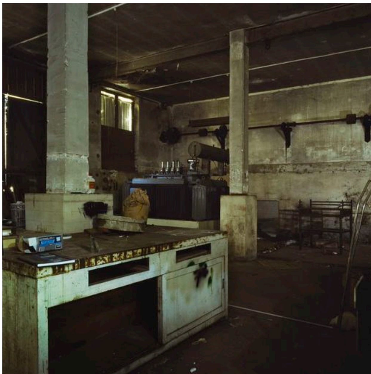
Laboratoire installé au sol-sol d'un des ateliers.
