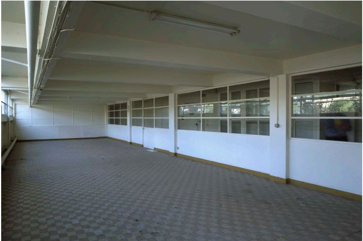
Réfectoire au sous-sol du bâtiment des bureaux.
