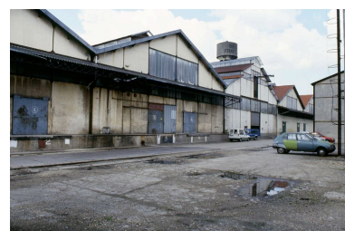
Quai de chargement le long de la feutrerie. Phot. Benoît Dufournier IVR22_19926000030ZA
