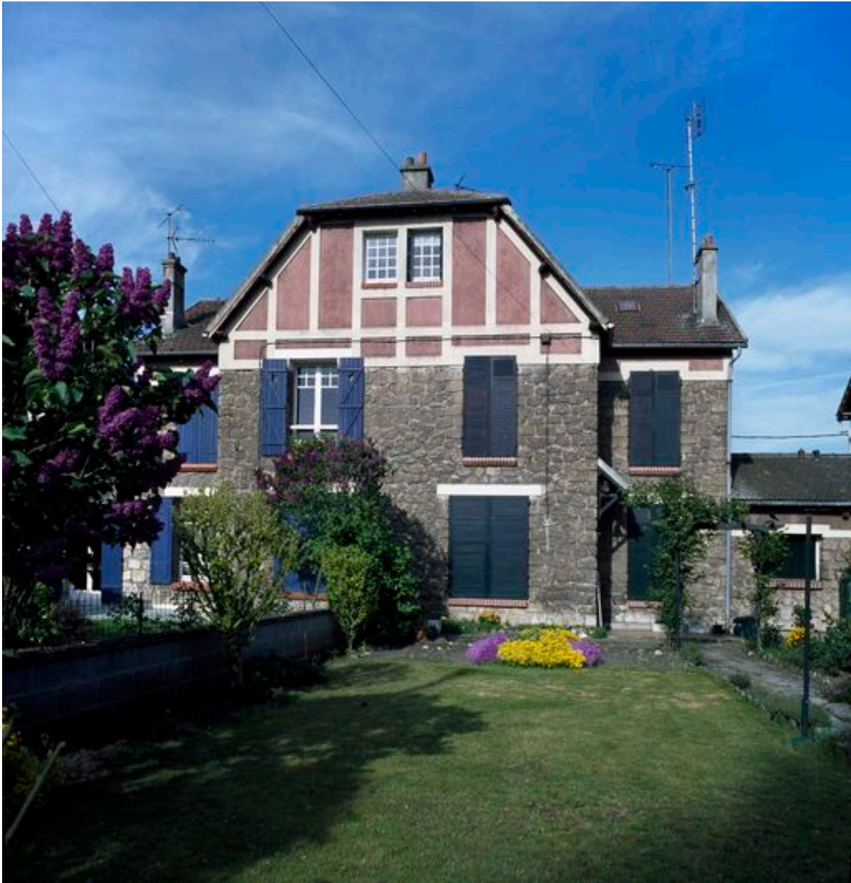
Maison jumelée de la cité.
