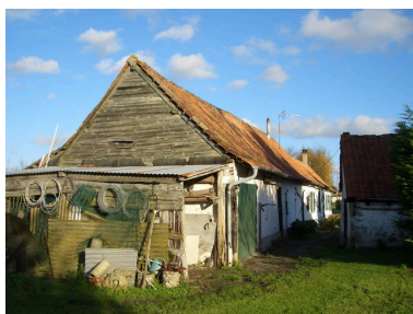
Vue latérale. Phot. Inès Guérin IVR22_20078005043NUCA
