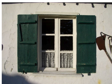
Détail de la fenêtre et de son contrevent. Phot. Inès Guérin IVR22_20078005045NUCA
