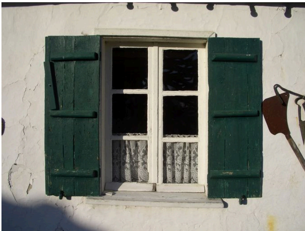
Détail de la fenêtre et de son contrevent.
