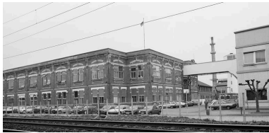
Atelier de fabrication ouest, vue partielle. Phot. Thierry Lefébure IVR22_19906000017X
