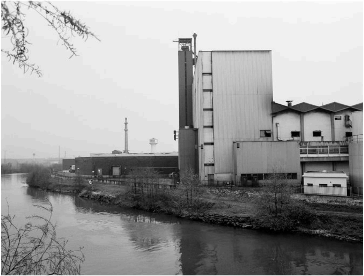
Ateliers de fabrication, vue partielle.
