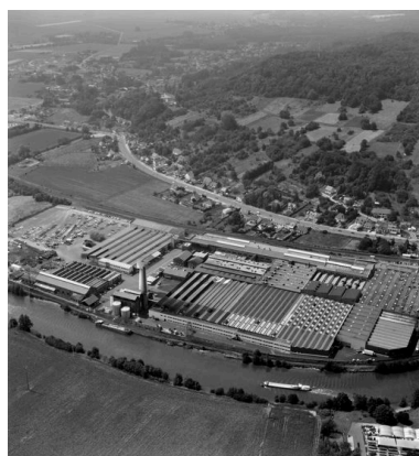
Vue aérienne générale de l'usine, en 1991. Phot. Phot'R IVR22_19916000267P
