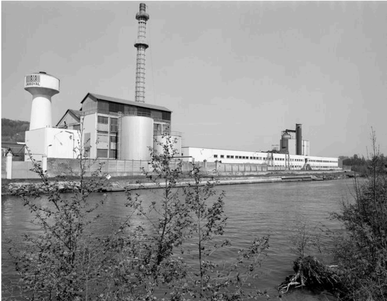
Ateliers de fabrication : vue générale, flanc est.
