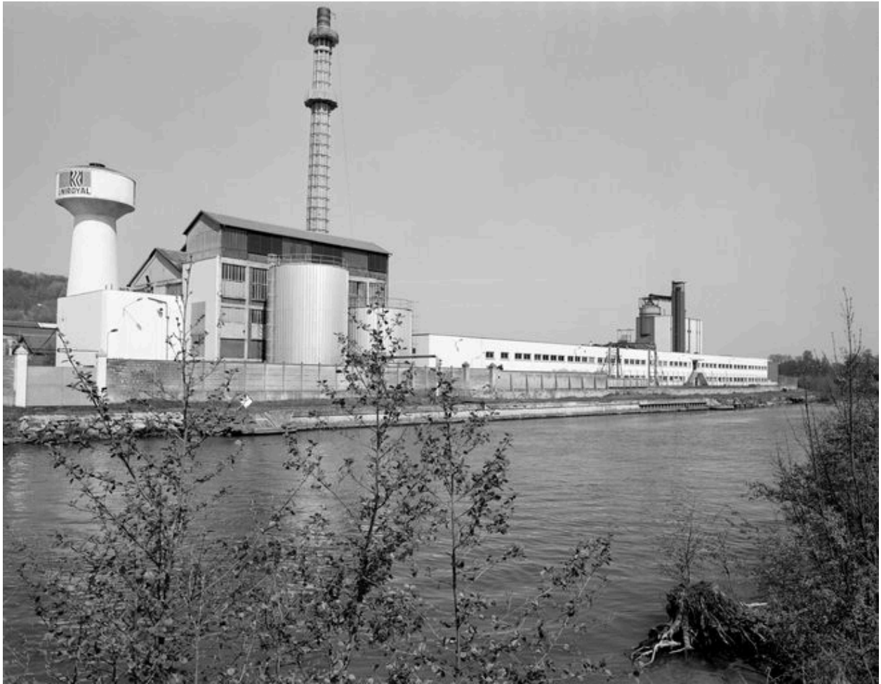
Ateliers de fabrication : vue générale, flanc est.
