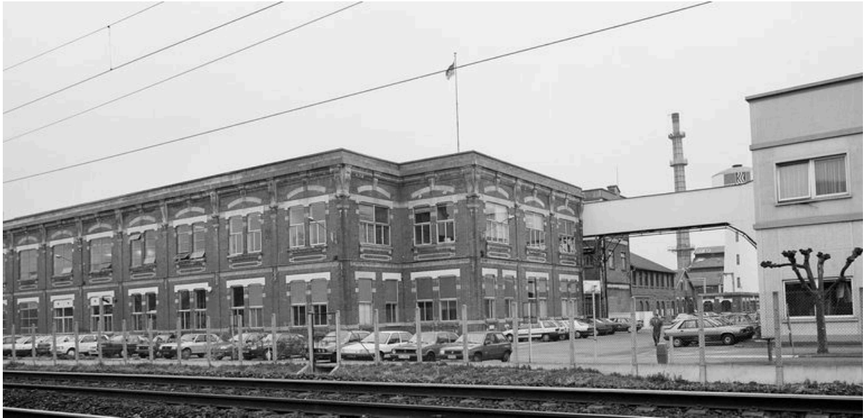
Atelier de fabrication ouest, vue partielle.
