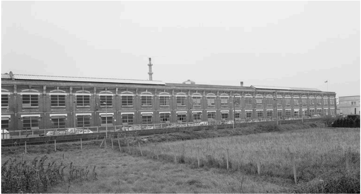
Atelier de fabrication ouest, vue partielle.
