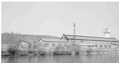
Magasin industriel, vue générale, flanc est. Phot. Thierry Lefébure IVR22_19906000025X
