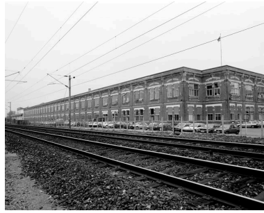
Atelier de fabrication de l'ancienne filature de viscose : vue générale ouest. Phot. Thierry Lefébure IVR22_19906000018X
