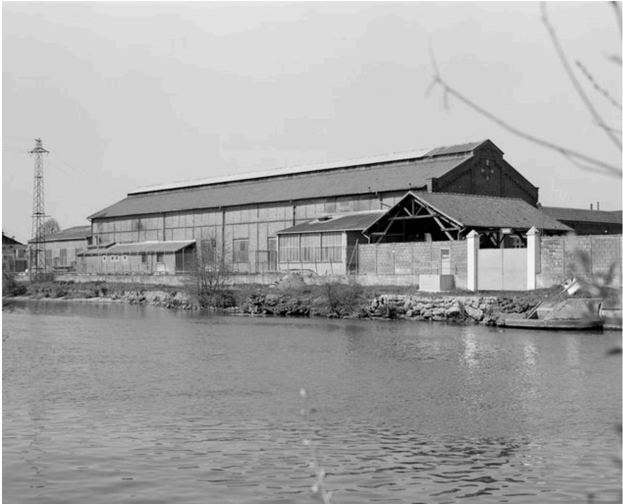
Magasin industriel : vue générale.
