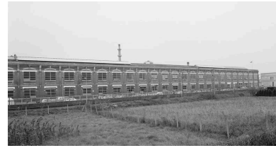
Atelier de fabrication ouest, vue partielle. Phot. Thierry Lefébure IVR22_19906000016X
