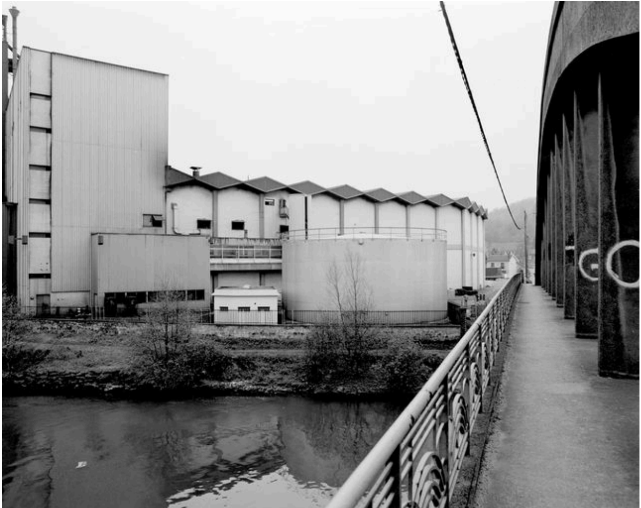
Ateliers de fabrication : vue partielle.
