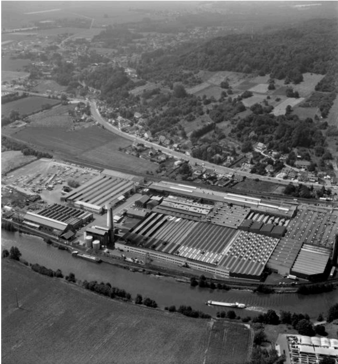
Vue aérienne générale de l'usine, en 1991.
