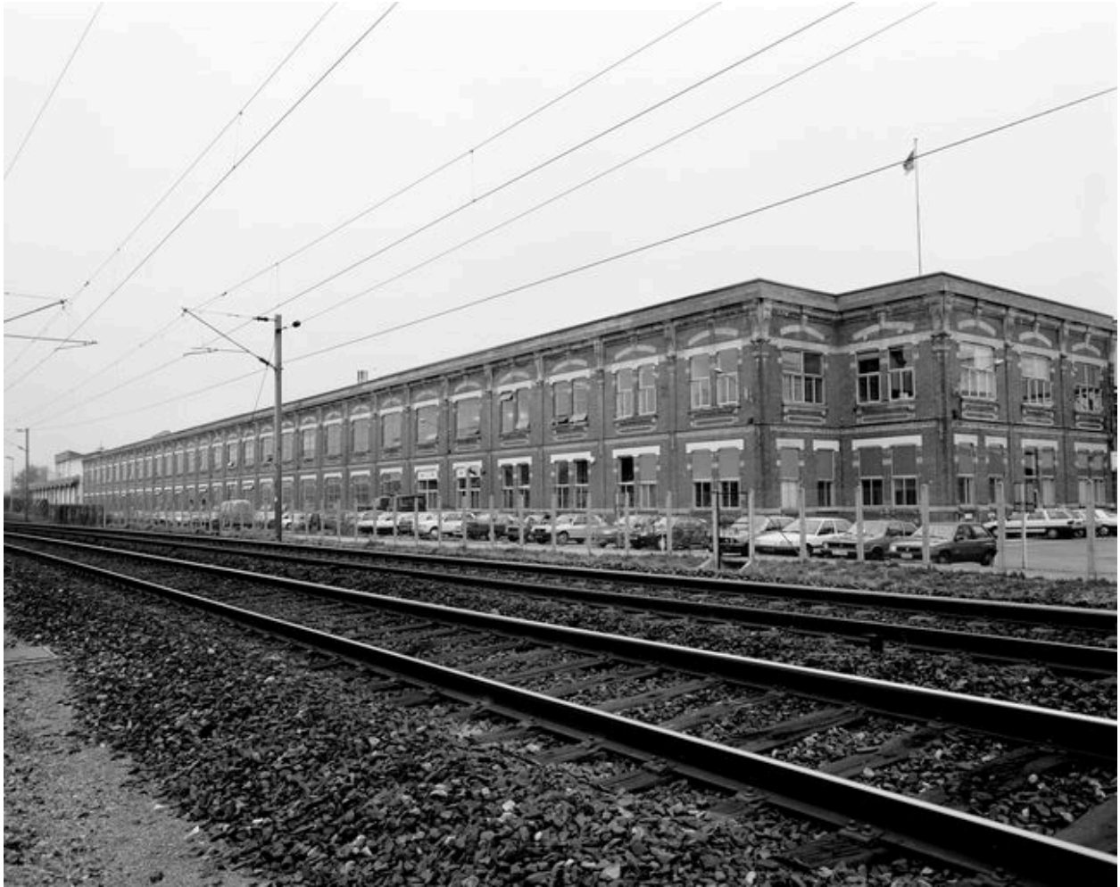
Atelier de fabrication de l'ancienne filature de viscose : vue générale ouest.
