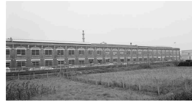
Atelier de fabrication ouest, vue partielle. Phot. Thierry Lefébure IVR22_19906000016X
