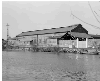
Magasin industriel : vue générale. Phot. Thierry Lefébure IVR22_19906000021X
