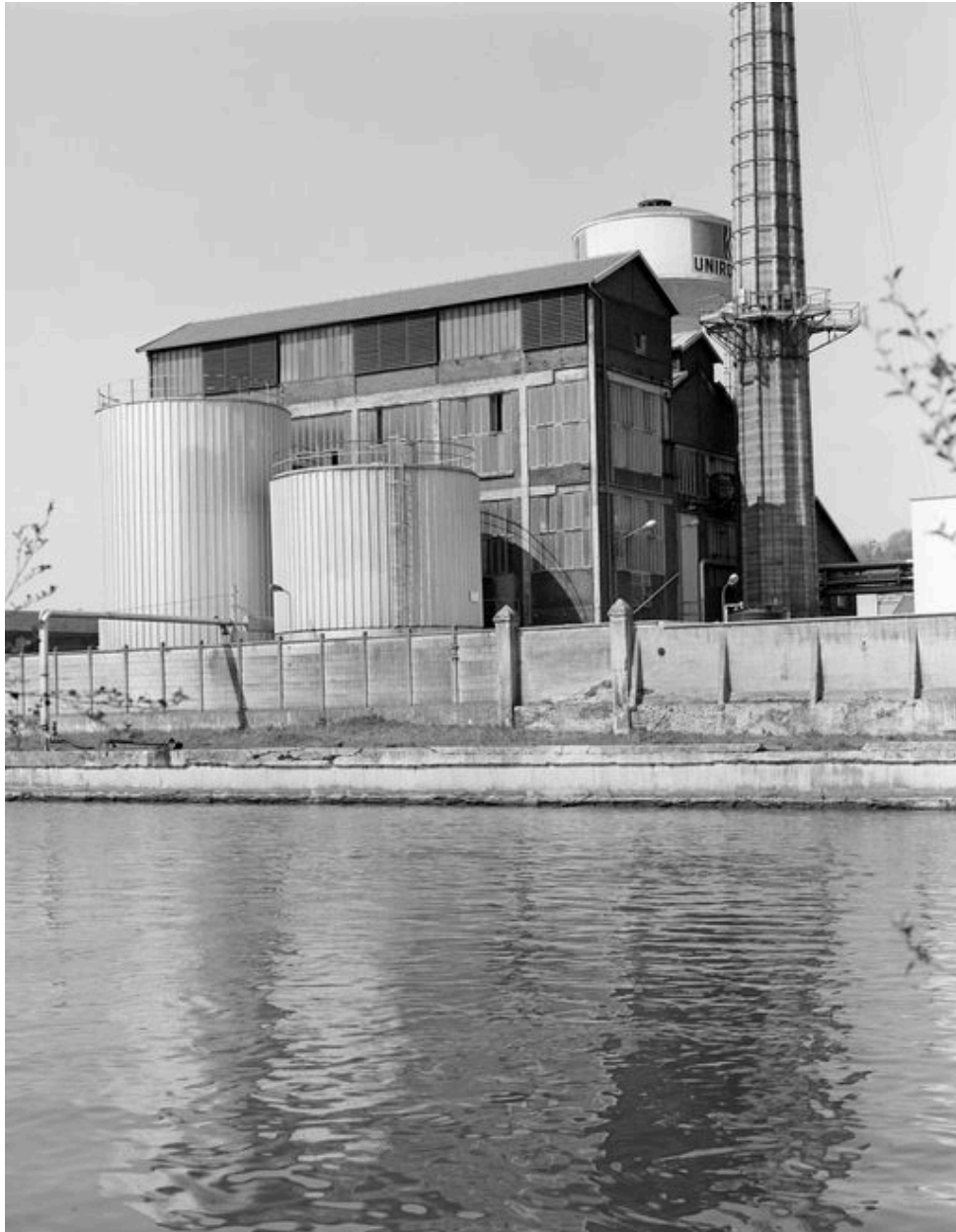
Atelier de fabrication et vue partielle d'un réservoir industriel.
