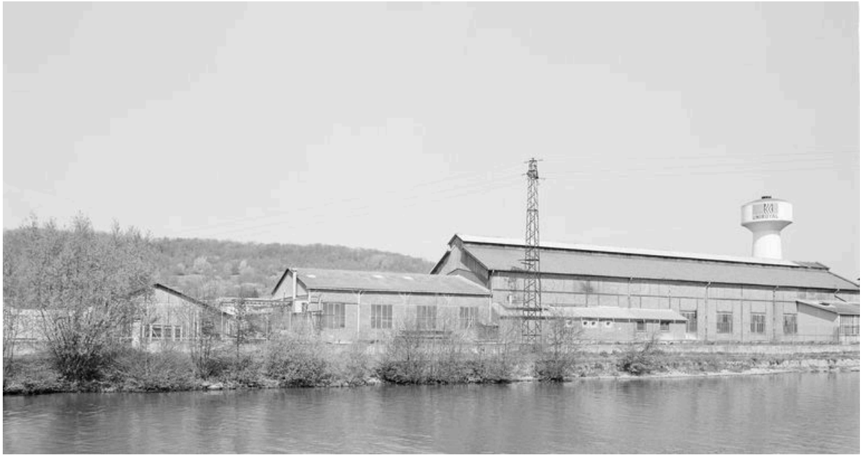
Magasin industriel, vue générale, flanc est.
