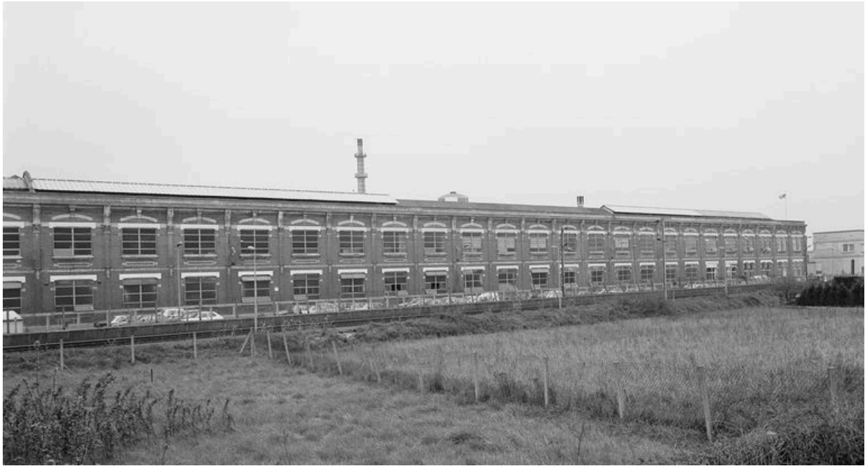
Atelier de fabrication ouest, vue partielle.
