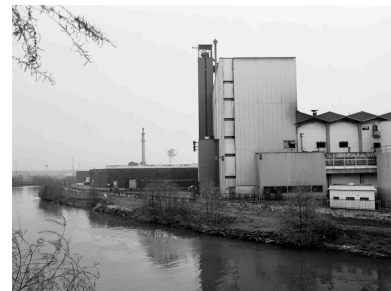
Ateliers de fabrication, vue partielle. Phot. Thierry Lefébure IVR22_19906000013X
