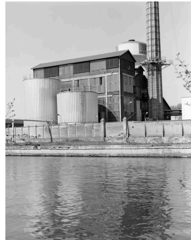
Atelier de fabrication et vue partielle d'un réservoir industriel. Phot. Thierry Lefébure IVR22_19906000020X
