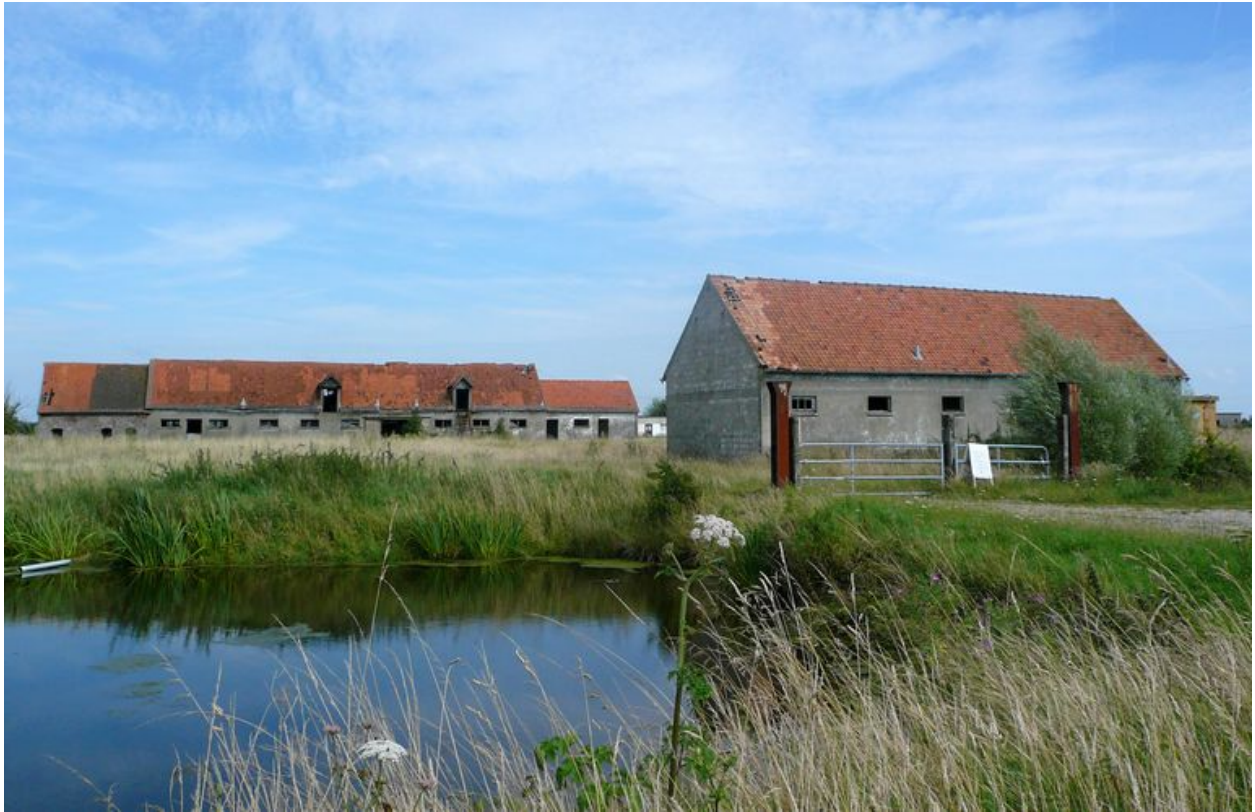
Vue sur les bâtiments nords.
