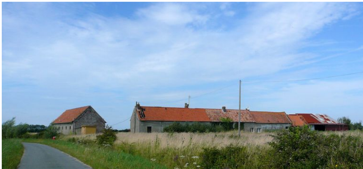
Vue générale (depuis le sud-ouest).
