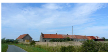
Vue générale (depuis le sud-ouest). Phot. Inès Guérin IVR22_20048001102NUCA
