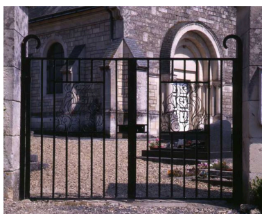
Vue de la grille du cimetière. Phot. Irwin Leullier IVR22_20050200827NUCA
