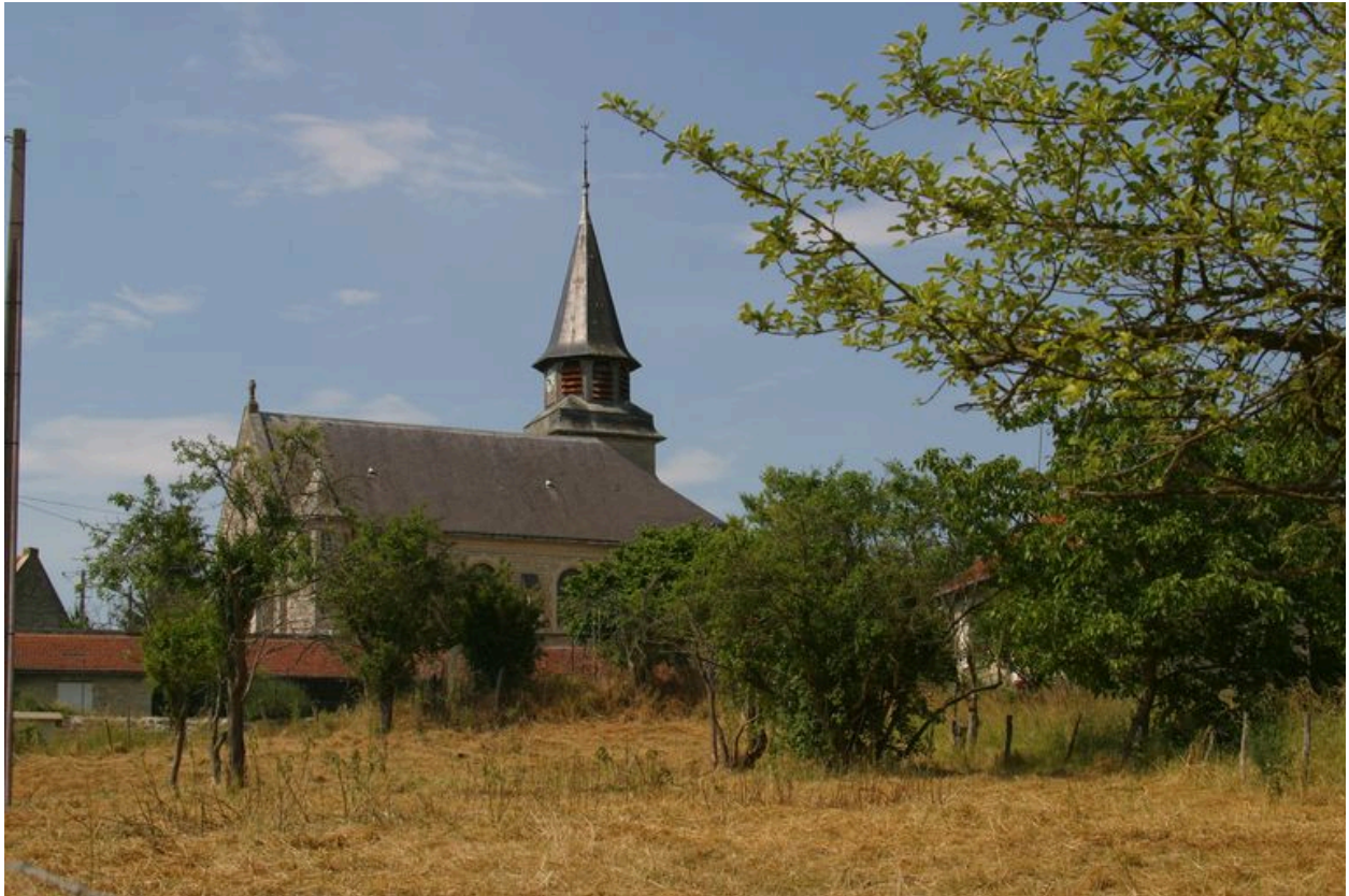
Vue latérale de l'église.
