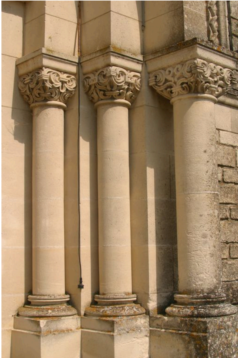
Détail des colonnes du portail.
