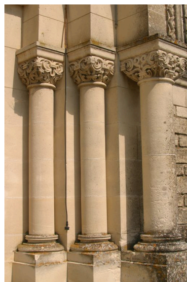
Détail des colonnes du portail. Phot. Inès Guérin IVR22_20050200808NUCA
