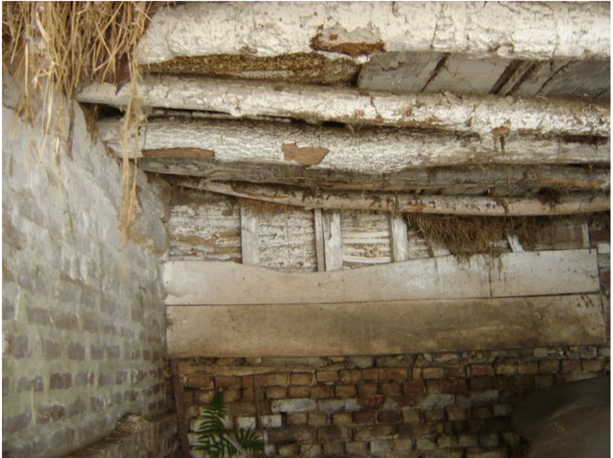
Vue détaillée du plafond.
