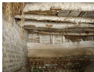
Vue détaillée du plafond. Phot. Inès Guérin IVR22_20058006081NUCA
