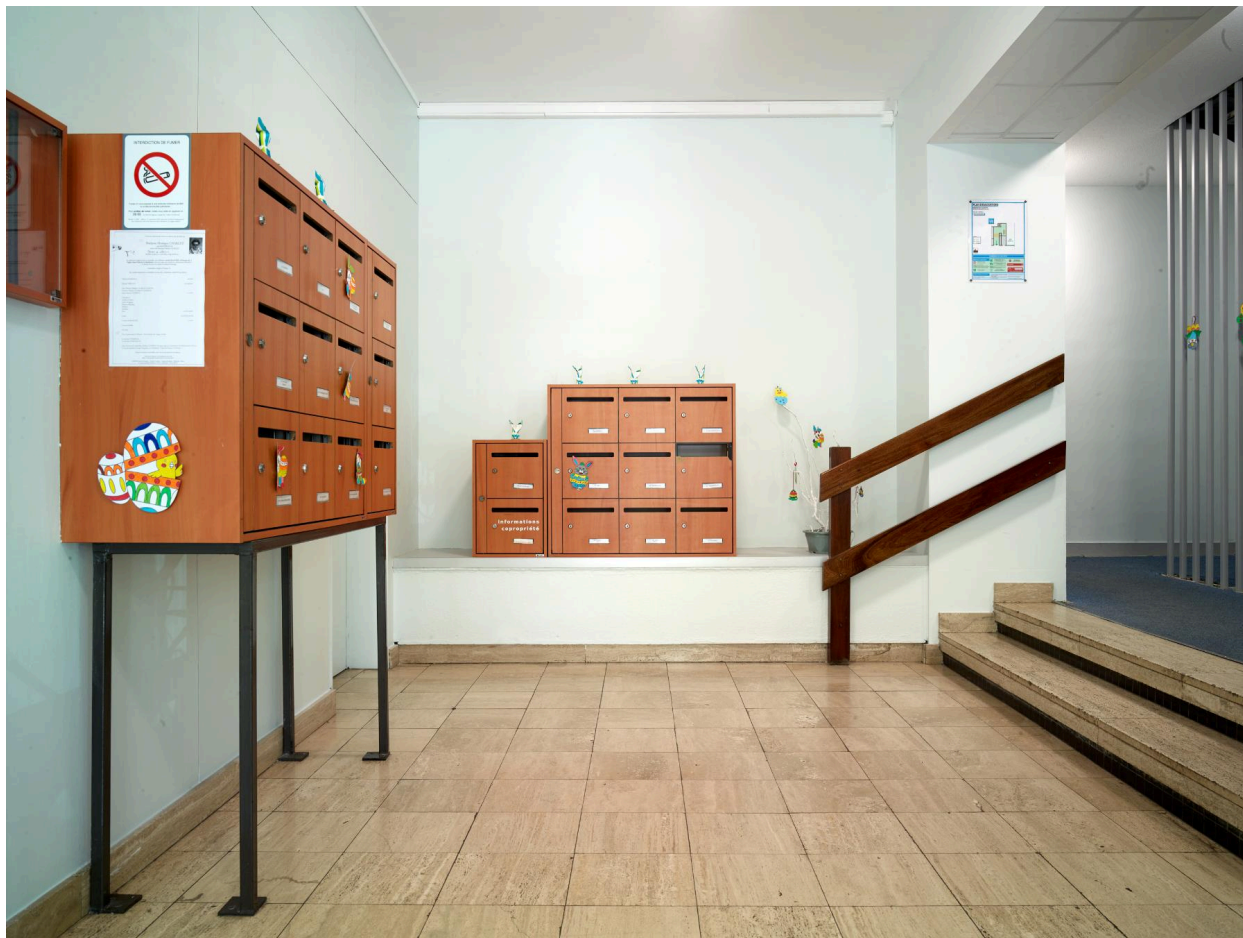
Hall d'entrée 2 de la tour C8 : panneau de mosaïque désormais recouvert d'un enduit.
