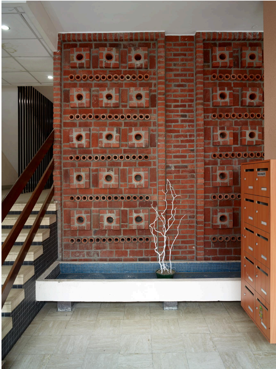
Détail du mur décoratif de brique à l'Intérieur du hall d'entrée 1 du n°27, porte C2.
