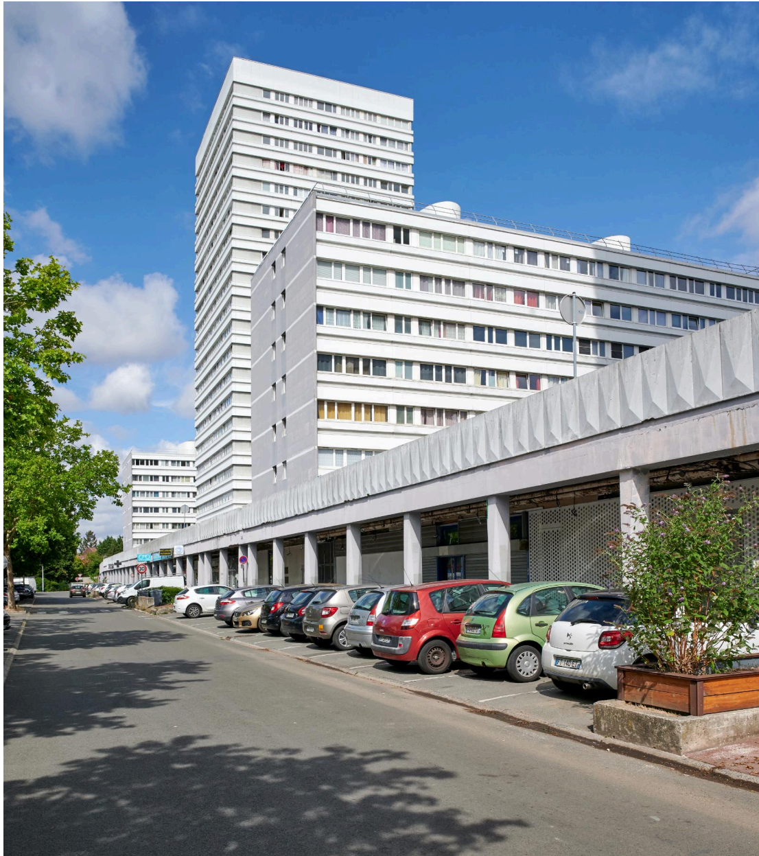
Vue générale vers l'ouest des immeubles de la résidence depuis le n°43.
