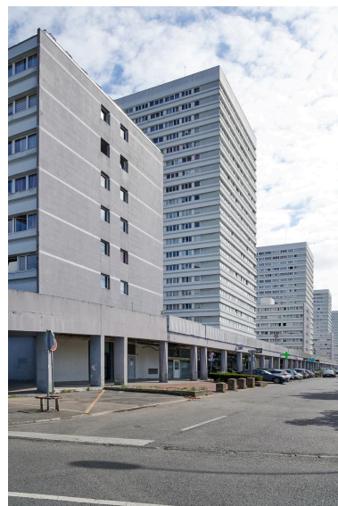
Vue générale vers l'est des immeubles de la Résidence de l'Europe, à partir du n°5. Phot. Pierre Thibaut IVR32_20225900729NUCA
