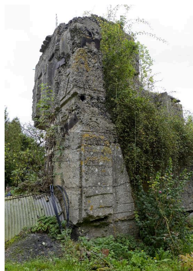
Vue vers l'est Phot. Jean-Marc Ramette IVR31_20145904203NUCA
