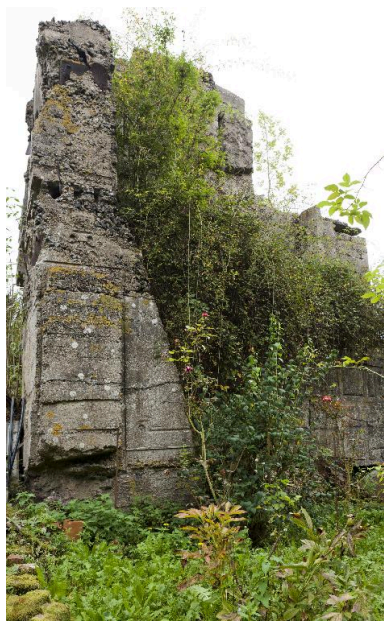
Vue vers l'est Phot. Jean-Marc Ramette IVR31_20145904191NUCA
