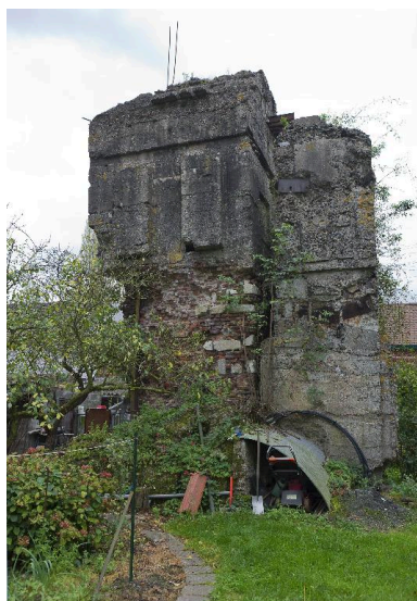
Elévation nord Phot. Jean-Marc Ramette IVR31_20145904202NUCA
