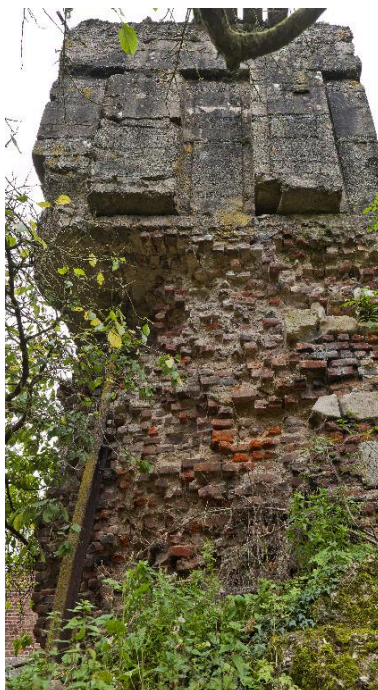
En contre-plongée de l'élévation nord : Détail du sous- bassement en brique et pierre surmonté de la casemate Phot. Jean-Marc Ramette IVR31_20145904208NUCA
