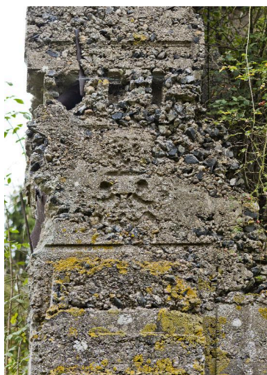
Détail du contrefort est : Angelots d'un bois de coffrage Phot. Jean-Marc Ramette IVR31_20145904205NUCA
