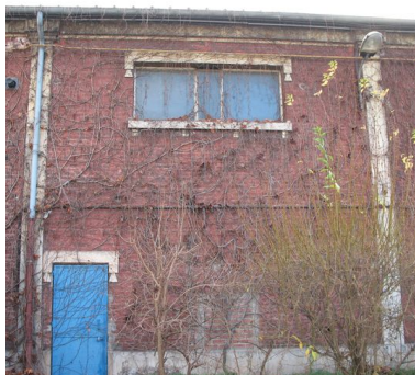
Détail de l'une des travées du mur nord de la salle des fêtes. Phot. Clarisse Lorieux IVR22_20066005118NUCA
