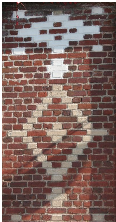
Détail de la mise en oeuvre des briques. Phot. Clarisse Lorieux IVR22_20066005053NUCA
