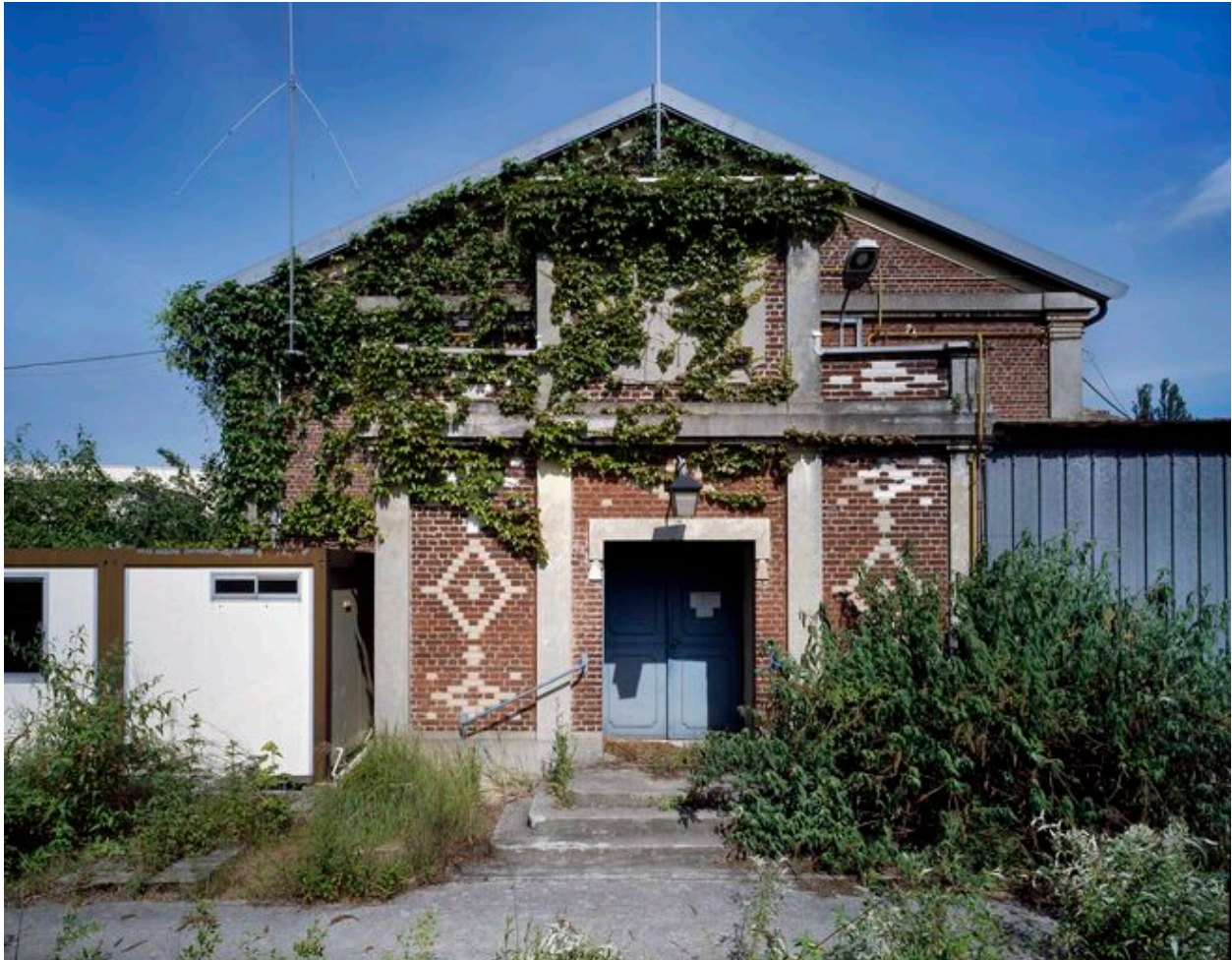
Façade principale de la salle des fêtes.
