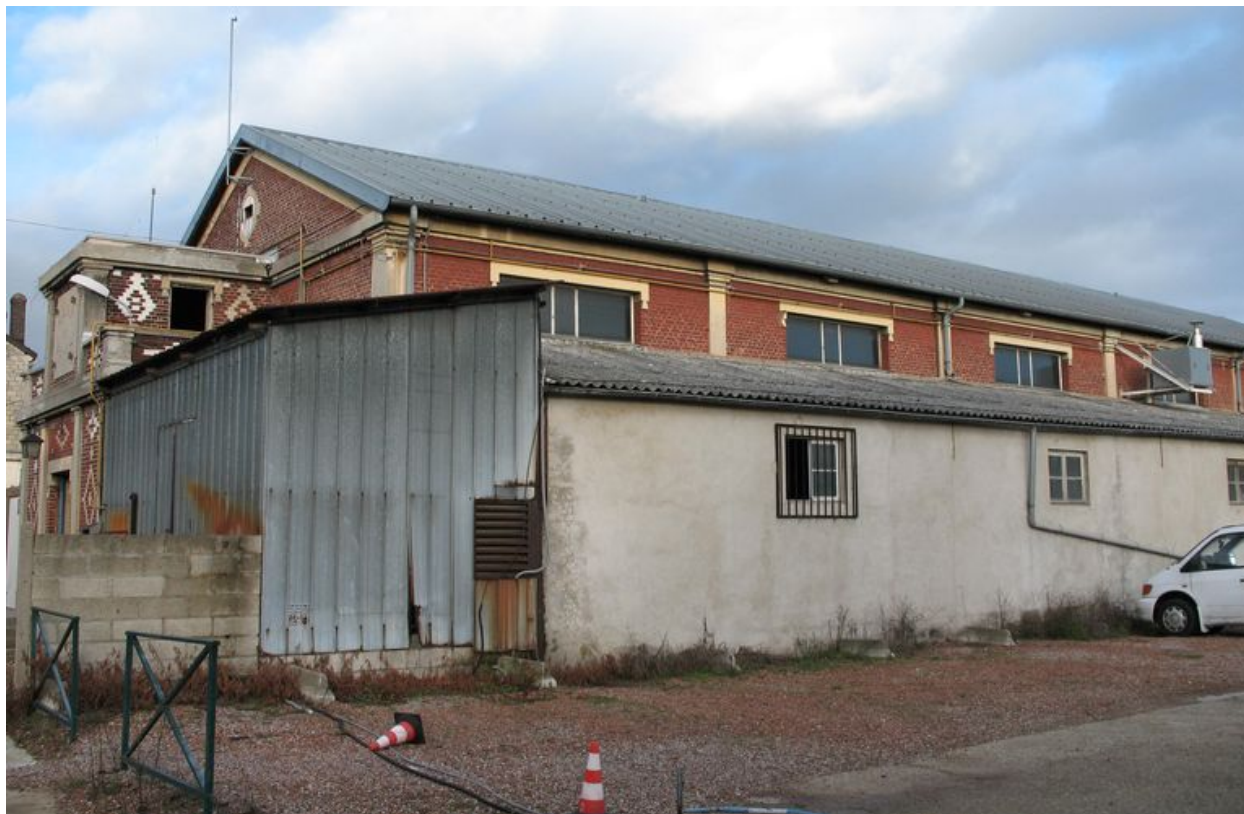
Mur sud et entrée de la salle des fêtes.
