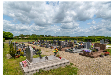
Vue générale depuis le sud-ouest de la partie récente du cimetière. Phot. Marc Kérignard IVR32_20236000669NUCA
