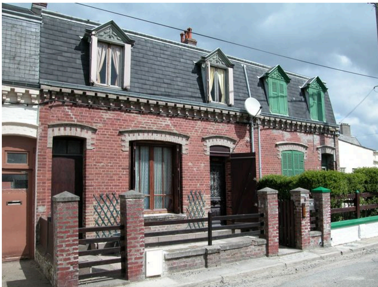
Détail de deux habitations (AZ 74 et 75).
