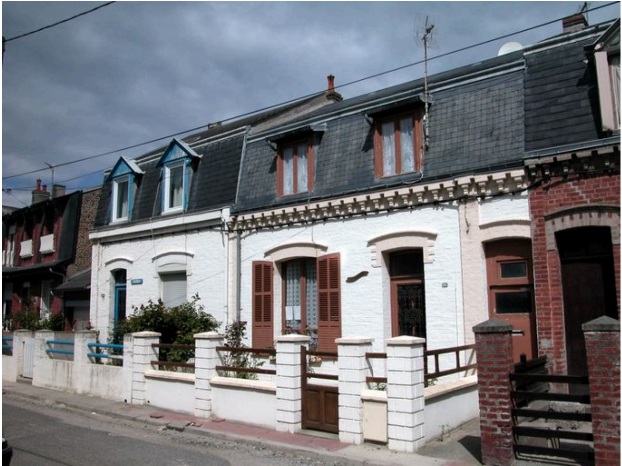
Détail de deux habitations (AZ 72 et 73).
