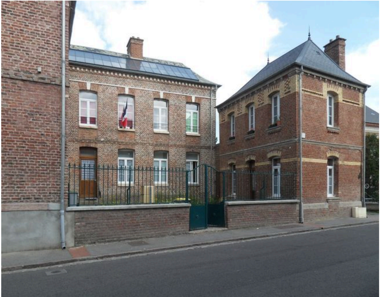
Le logement de l'institutrice construit en 1908, sur les plans de l'architecte Bienaimé.
