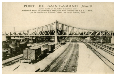
Pont de chemin de fer à deux travées de 45 m, réalisé par l'usine de construction Edmond Coignet, Paris, carte postale sans date (2e quart 20e siècle) (Médiathèque Saint-Amand-les-Eaux). IVR31_20135908107NUCA
