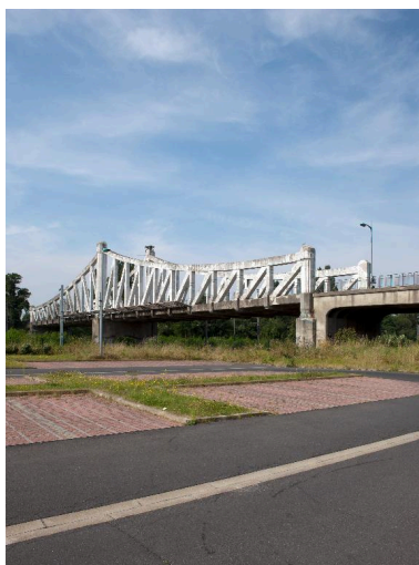
Vue générale du pont béton du chemin de fer. Phot. Pierre Thibaut IVR31_20125902049NUCA
