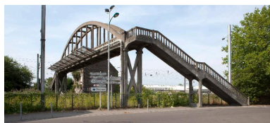
Passerelle piétonne située face à la rue Marillon permettant d'enjamber le chemin de fer. Phot. Pierre Thibaut IVR31_20125902048NUCA
