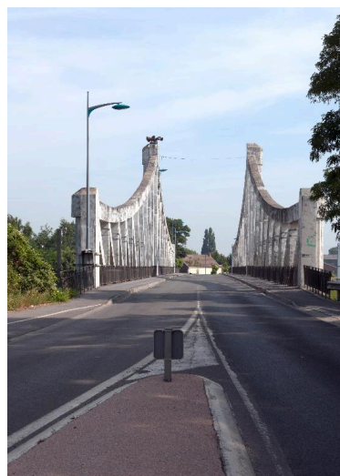
Vue de face du pont de chemin de fer. Phot. Pierre Thibaut IVR31_20125902053NUCA
