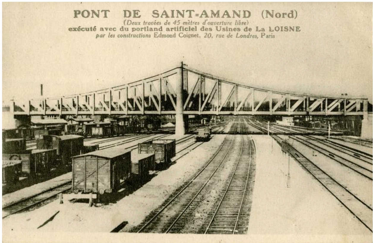
Pont de chemin de fer à deux travées de 45 m, réalisé par l'usine de construction Edmond Coignet, Paris, carte postale sans date (2e quart 20e siècle) (Médiathèque Saint-Amand-les-Eaux).
