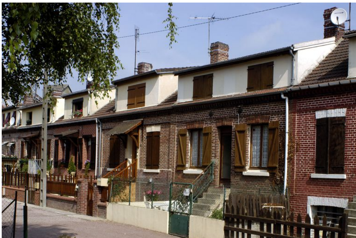
Détail des maisons dotées d'une lucarne de toit postérieure à la construction.
