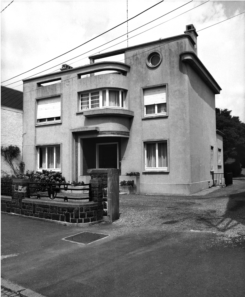
Vue générale de la maison, après sablage.
