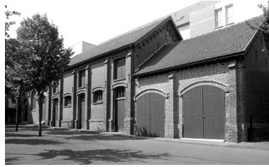
Remise à automobile. Phot. Laurent Jumel IVR22_19966002612X
