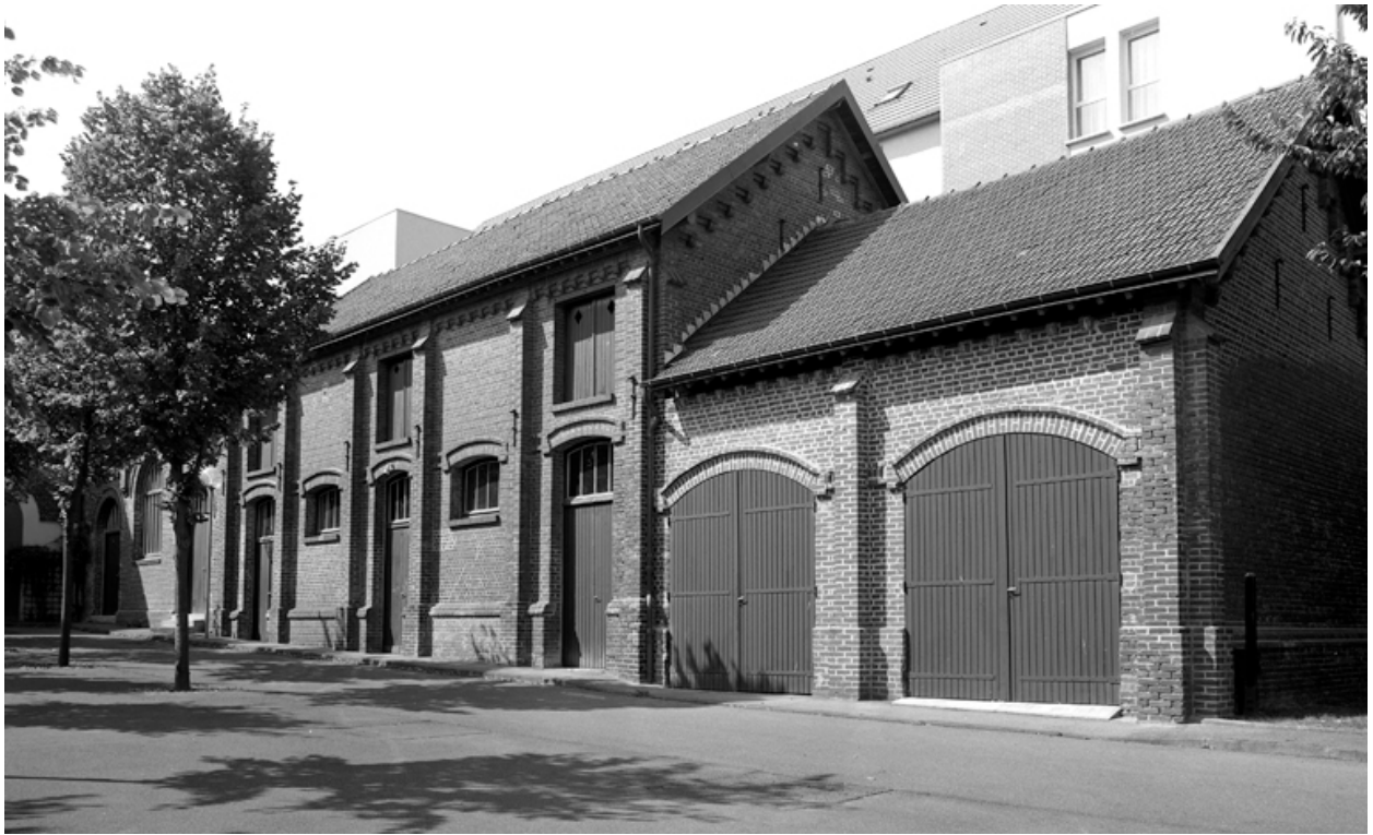
Remise à automobile.
