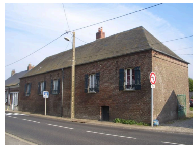
Vue générale. Phot. Inès Guérin IVR22_20078005258NUCA
