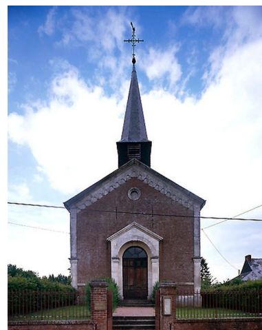
Vue générale de la façade occidentale. Phot. Franck Bürjes IVR22_19990202818VA
