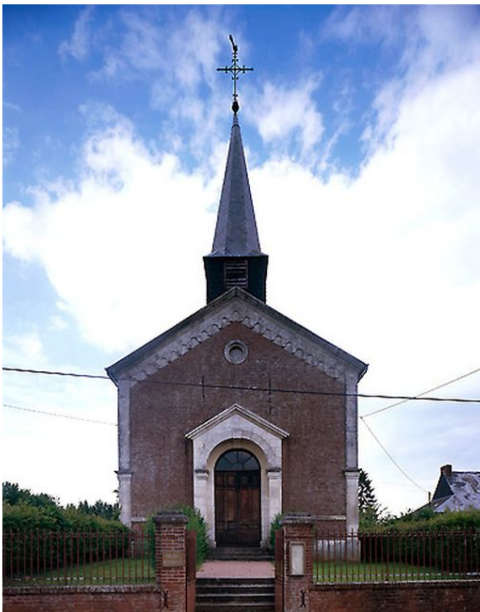
Vue générale de la façade occidentale.
