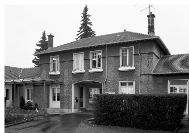
Les bureaux, façade est. Phot. Thierry Lefébure IVR22_19986000064X
