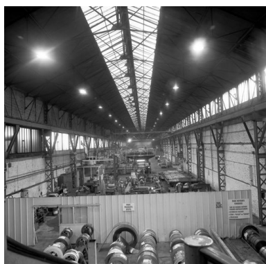
Intérieur de l'atelier de fabrication (laminage et tréfilerie) avec la charpente métallique apparente. Phot. Thierry Lefébure IVR22_19986000073X
