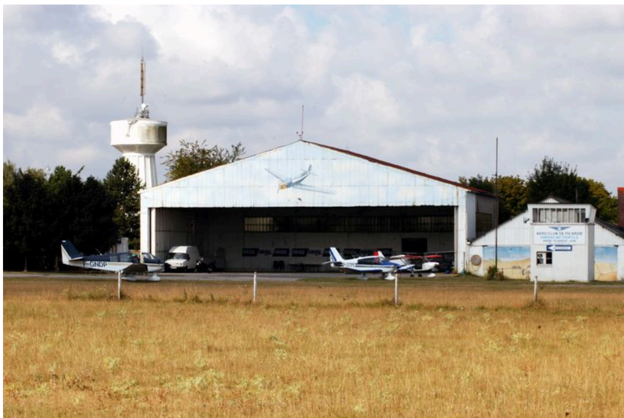
Vue du hangar.
