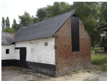
Vue de la grange située en fond de cour. Phot. Inès Guérin IVR22_20078005341NUCA
