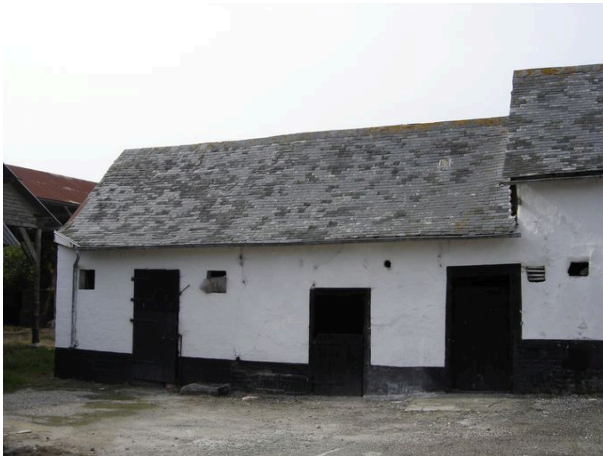
Vue des étables depuis la cour.
