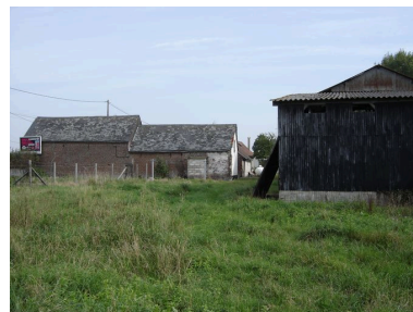
Vue postérieure des bâtiments agricoles depuis la prairie qui borde la propriété. Phot. Inès Guérin IVR22_20078005345NUCA
