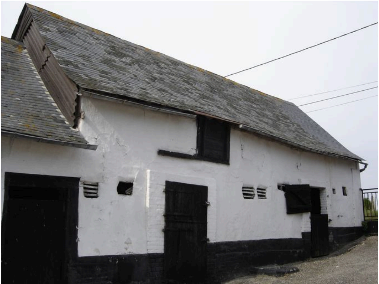
Vue des étables sur rue.
