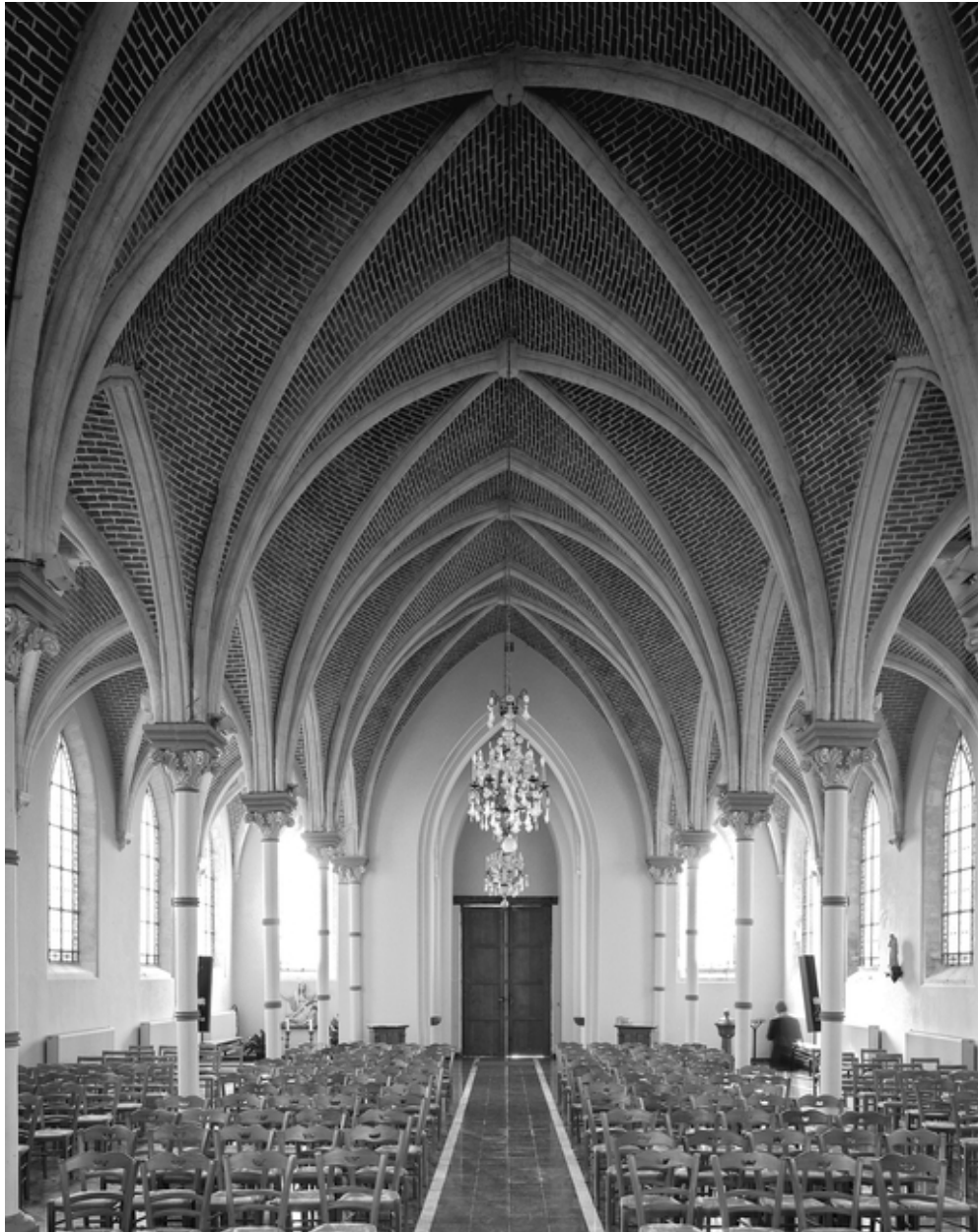
Vue générale intérieure vers l'entrée.
