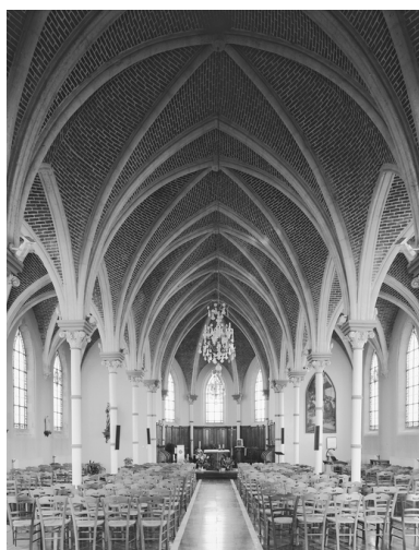
Vue générale intérieure vers le chœur. Phot. Philippe Dapvril IVR31_20045900147V
