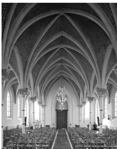
Vue générale intérieure vers l'entrée. Phot. Philippe Dapvril IVR31_20045900148V
