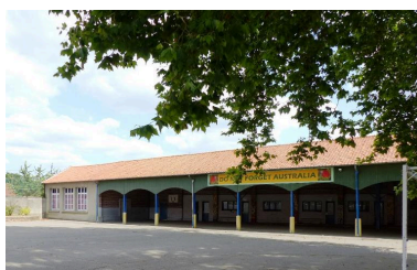
Le préau, au sud de la cour. Phot. Isabelle Barbedor IVR32_20168005782NUCA
