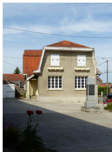
L'ancien logement du directeur de l'école (actuel pavillon Marie-Gossart). Vue depuis l'est. Phot. Isabelle Barbedor IVR32_20208005038NUCA
