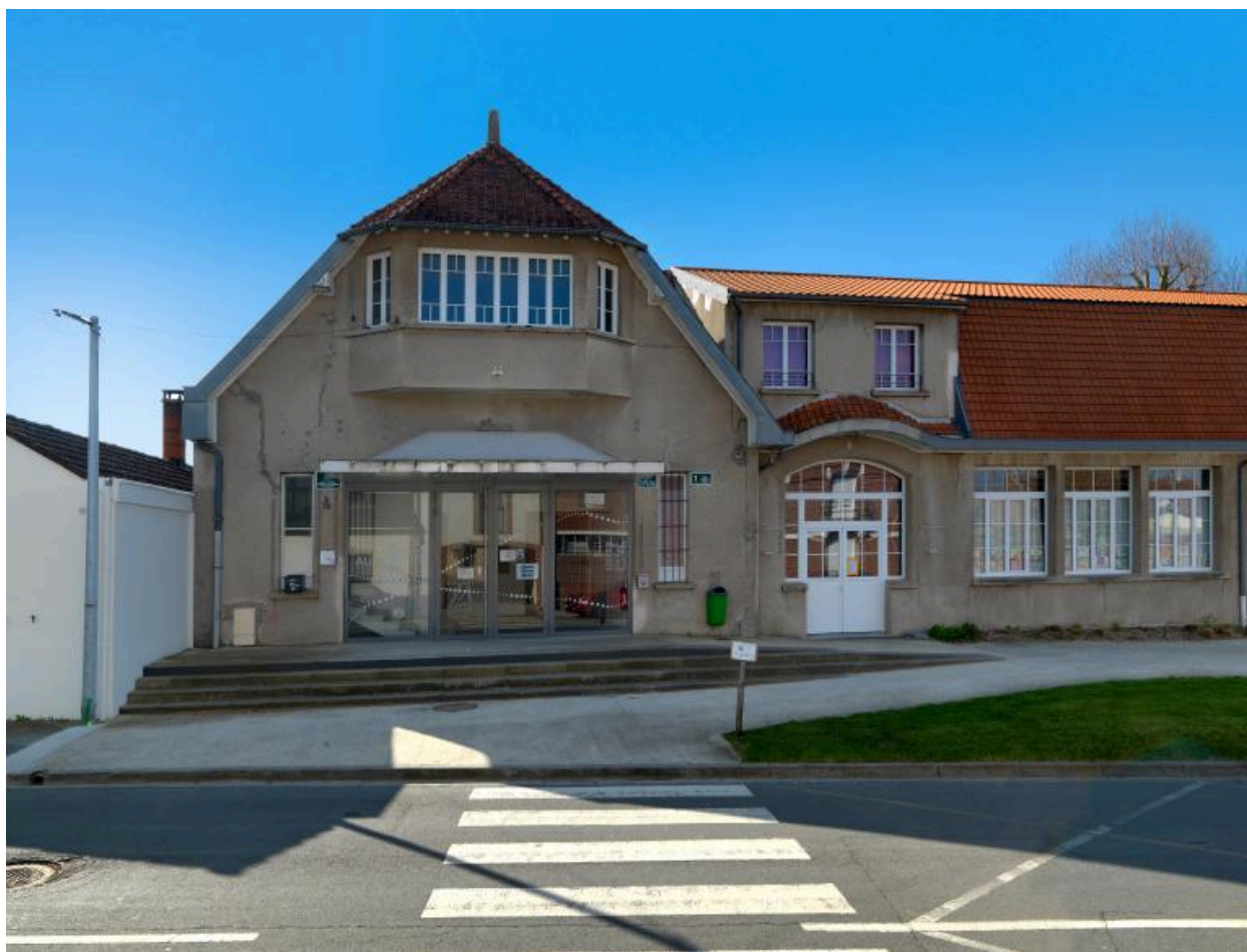
Vue du pavillon est abritant la salle des fêtes. Actuelle entrée du musée australien.
