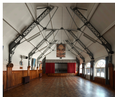
Vue intérieure de la salle des conférences. La charpente métallique et la scène. Phot. Thierry Lefébure IVR32_20208000151NUC2AQ
