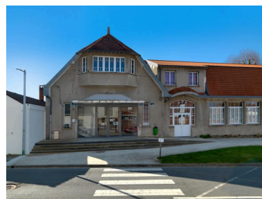
Vue du pavillon est abritant la salle des fêtes. Actuelle entrée du musée australien.
