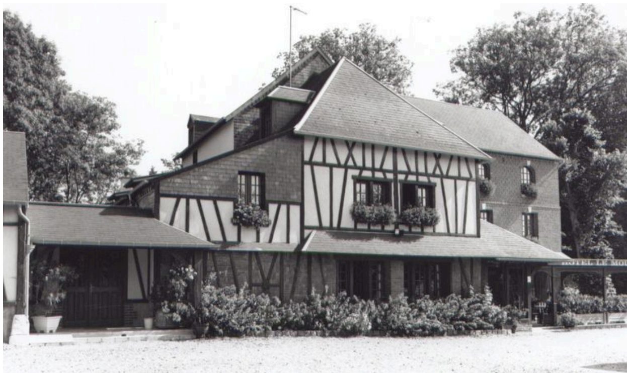
Vue d'ensemble du bâtiment en retour sur cour.
