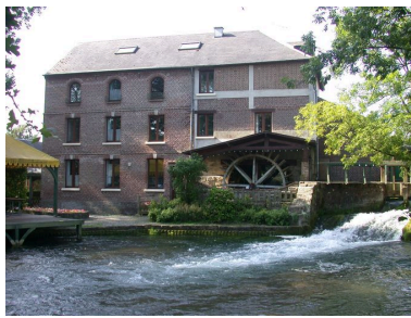
Vue d'ensemble postérieure de la minoterie. Phot. Bertrand Fournier IVR22_20026000867NUCA
