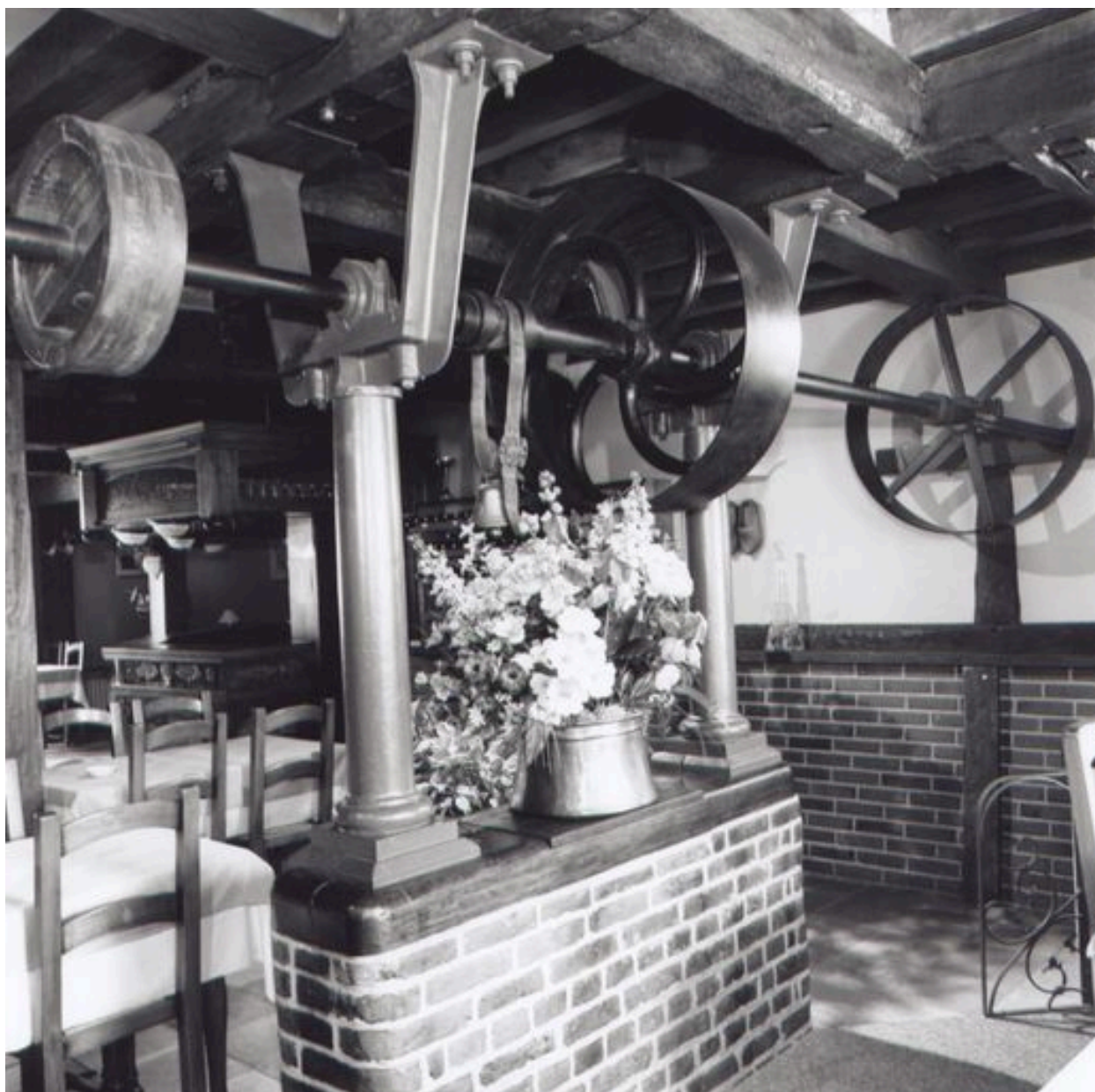
Intérieur, arbre horizontal et les poulies de transmission.
