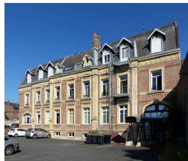
Vue depuis la cour. Phot. Isabelle Barbedor IVR32_20188005040NUCA
