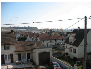
Toits des maisons de la cité Marinoni. Phot. Clarisse Lorieux IVR22_20086005152NUCA
