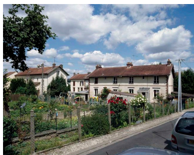
Maison ouvrière de la cité Marinoni. Phot. Thierry Lefébure IVR22_20106000759NUCA
