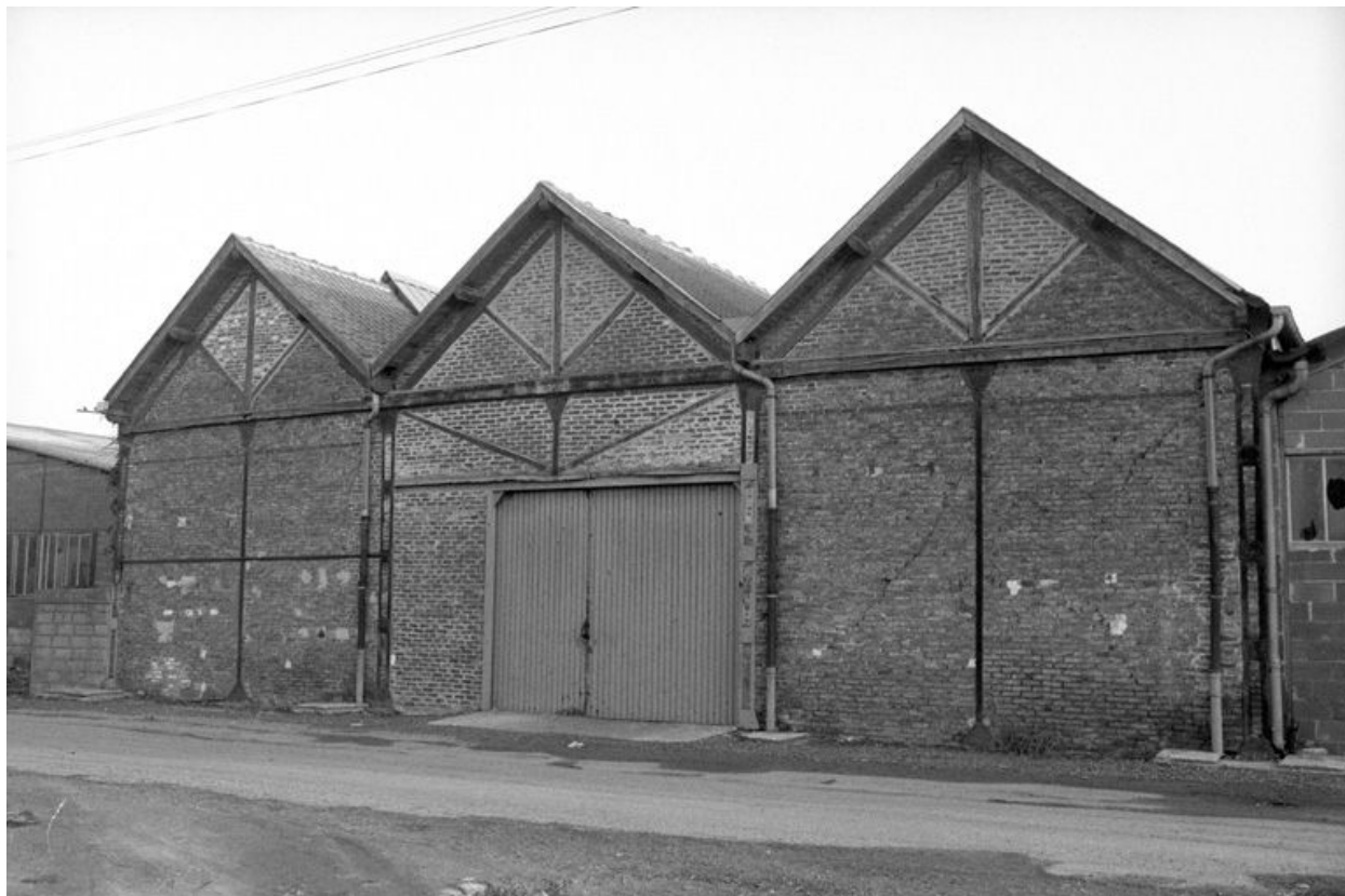
Entrepôt industriel sud, flanc ouest.
