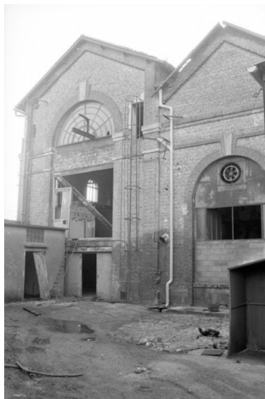
Vue de la façade nord de la salle des machines. Phot. Francis Dubuc IVR22_19908001482Z
