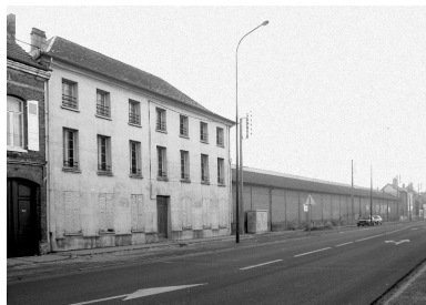
Vue partielle depuis la chaussée de Rouvroy. Phot. Francis Dubuc IVR22_19908001479Z
