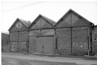
Entrepôt industriel sud, flanc ouest. Phot. Francis Dubuc IVR22_19908001480Z
