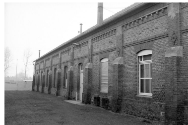
Vue du bâtiment sud. Phot. Francis Dubuc IVR22_19908001481Z
