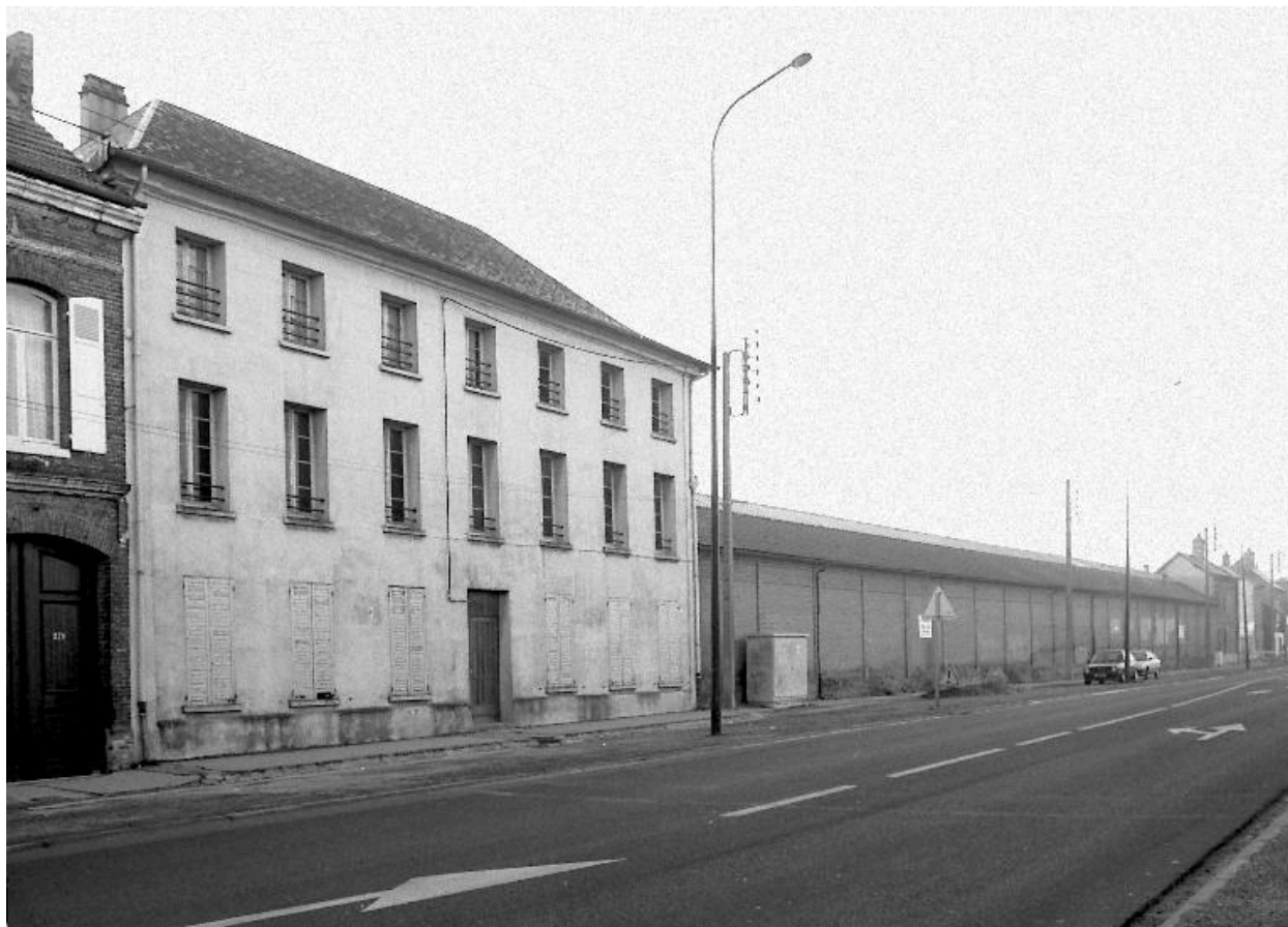
Vue partielle depuis la chaussée de Rouvroy.
