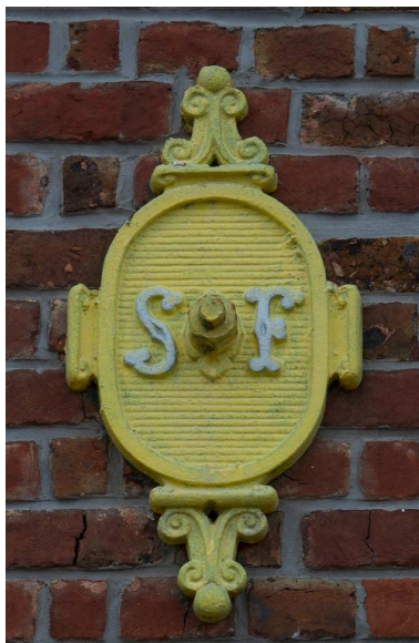
Fer d'ancrage du bâtiment subsistant en fond de parcelle. Phot. Marie-Laure Monnehay-Vulliet IVR32_20188000568NUC2A
