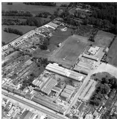
Vue aérienne de 1990, flanc nord-ouest. Phot. Phot'R IVR22_19908001652P
