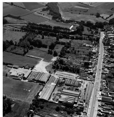
Vue aérienne de 1990, flanc nord-est. Phot. Phot'R IVR22_19908001650P
