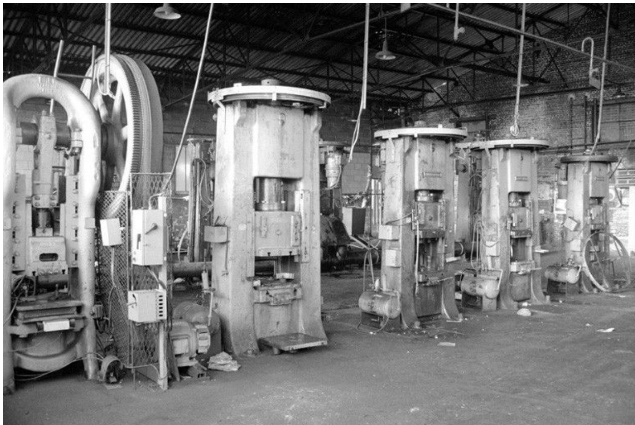
Salle des machines, vue intérieure.
