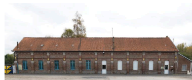
Bâtiment subsistant en fond de parcelle. Phot. Marie-Laure Monnehay-Vulliet IVR32_20188000595NUC2A
