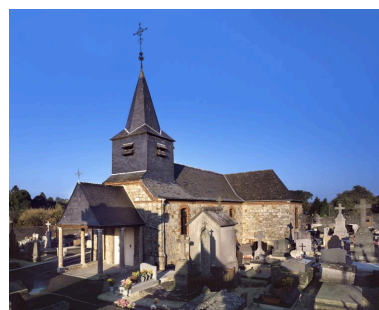
Vue générale de la chapelle, depuis l'Ouest. Phot. Thierry Lefébure IVR22_19990206242VA
