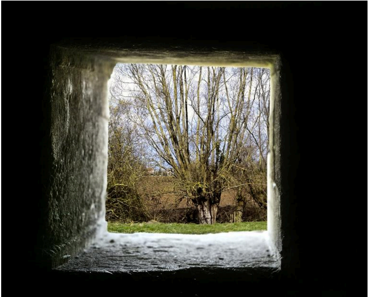
Vue intérieure, embrasure pour communication lumineuse pointant vers le nord-ouest
