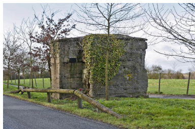
Vue vers le sud-ouest Phot. Jean-Marc Ramette IVR31_20145904453NUCA
