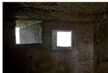
Vue intérieure, embrasures pour communication lumineuse Phot. Jean-Marc Ramette IVR31_20145904447NUCA
