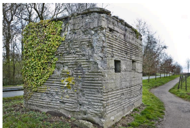
Vue vers le sud Phot. Jean-Marc Ramette IVR31_20145904450NUCA
