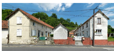
Vue d'ensemble sur rue de la cité ouvrière. Phot. Thierry Lefébure IVR22_20128000293NUC2AQ
