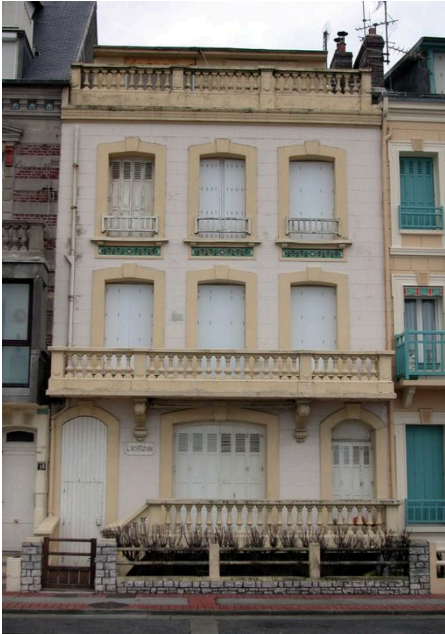
Vue d'ensemble depuis l'esplanade.
