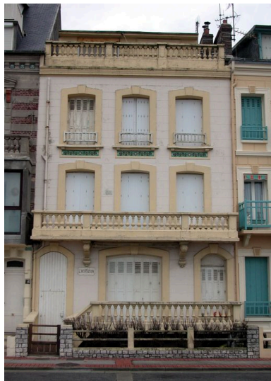
Vue d'ensemble depuis l'esplanade.
