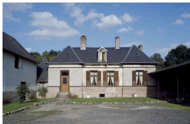
Vue générale du logis de fond de cour.
