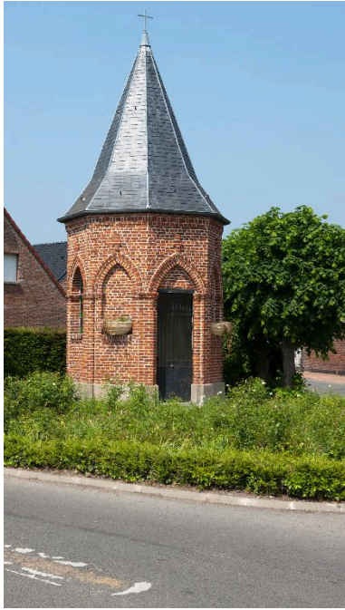
Vue générale. Phot. Pierre Thibaut IVR31_20125901779NUCA
