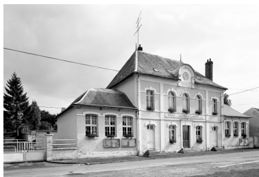
Vue d'ensemble de la façade.
