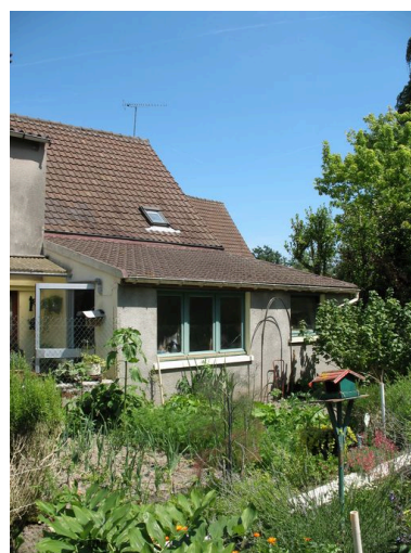
Vue générale du bâtiment qui abritait l'ancienne distillerie. Phot. Clarisse Lorieux IVR22_20096005049NUCA
