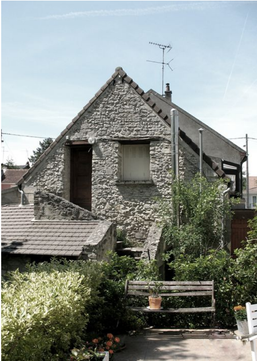
Mur pignon de l'ancienne distillerie.
